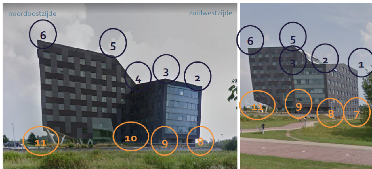
Figuur 4.28: Locaties van de gebruikte observatiepunten op Meander 1101. Bron foto: Google Streetview.
