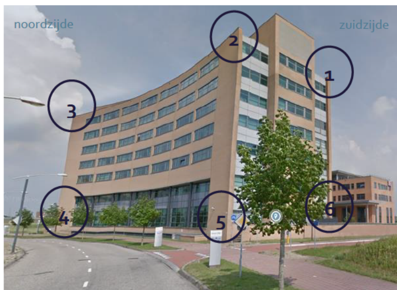
Figuur 4.33: Locaties van de gebruikte observatiepunten op Meander 1051. Bron foto: Google Streetview.
