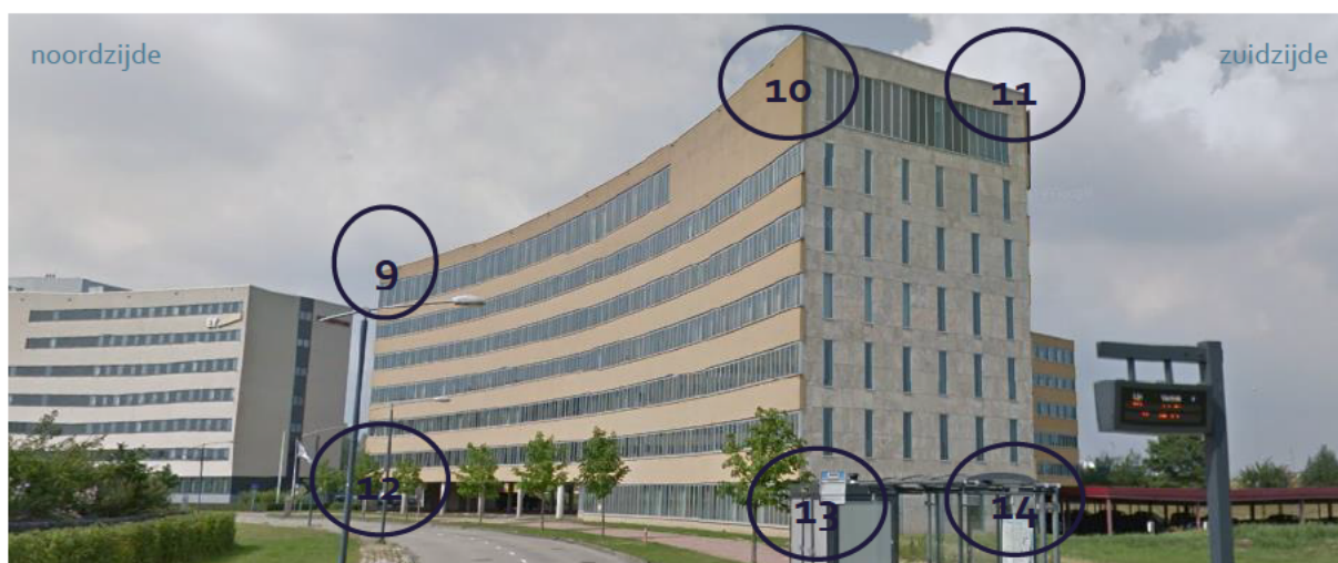
Figuur 4.39: Locaties van de gebruikte observatiepunten op Meander 901. Bron foto: Google Streetview.
