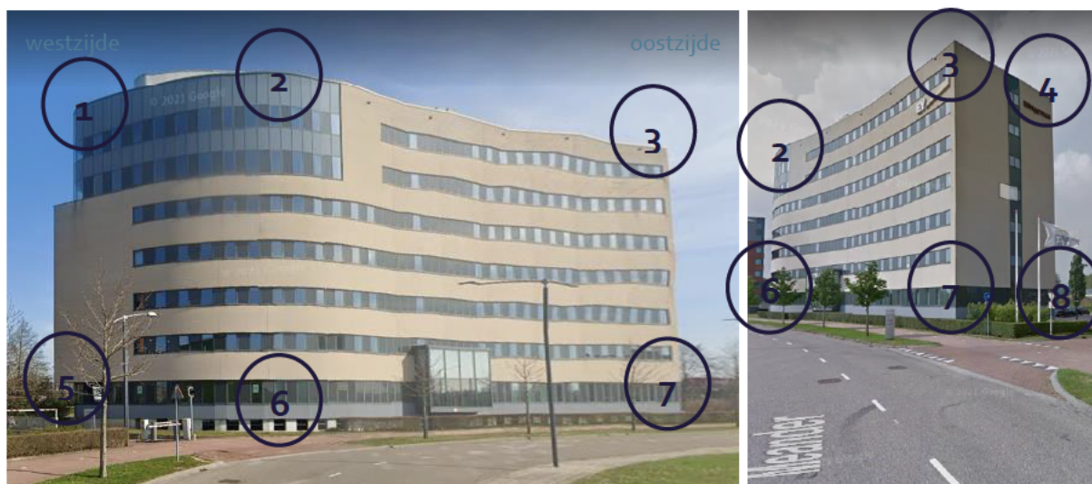
Figuur 4.45: Locaties van de gebruikte observatiepunten op Meander 861. Bron foto: Google Streetview.
