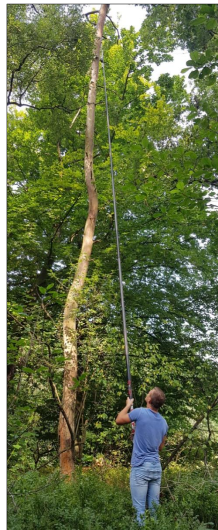
Figuur 15. Inspectie boomholte.
