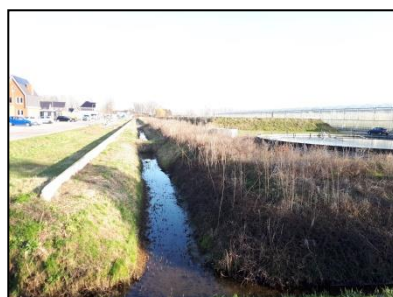
Figuur 7. Sloot aan de westzijde van de onderzoekslocatie.
