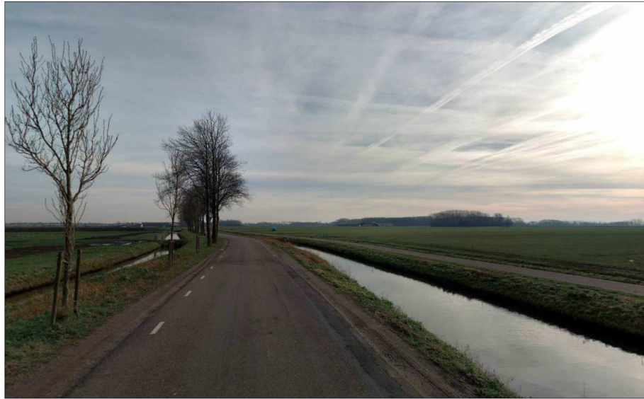
Figuur 4.3: Inrichting van de Uilkerweg buiten de bebouwde kom
