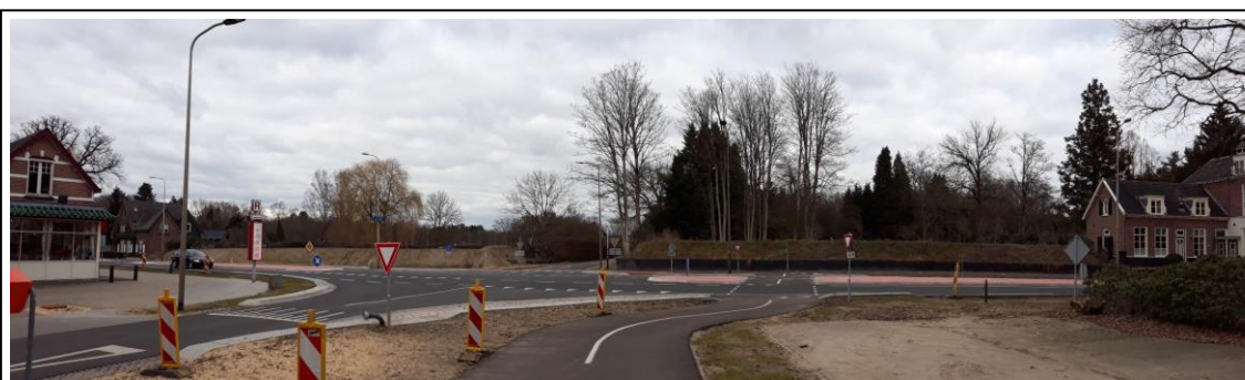
Figuur 8 – Huidige kruising N348 – Quatre Brasweg / Flierderweg (na herinrichting), gezien vanuit het westen
