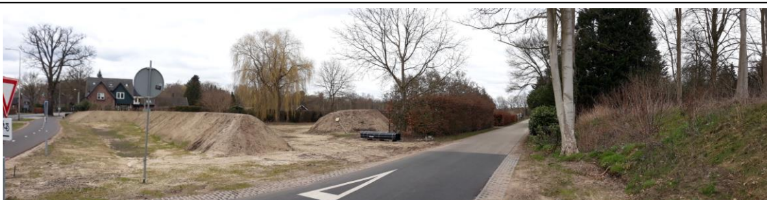
Figuur 6 – Foto perceel Zutphenseweg 23, na sloop van de woning en na de herinrichting van de kruising N348 – Quatre Brasweg / Flierderweg, met aan de linkerzijde de gerealiseerde wadi en de grondwal
