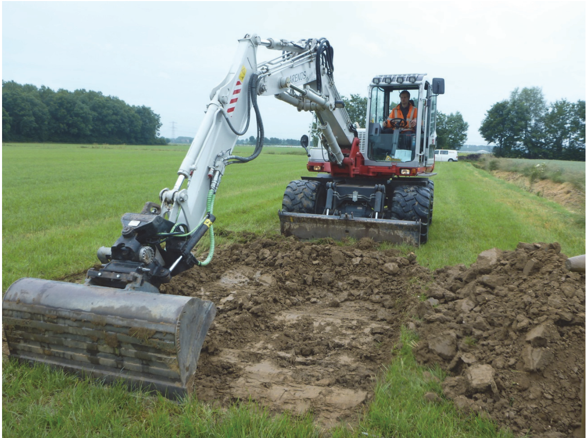
Fig. 1.2: Aanvang van de werkzaamheden (wp3).
