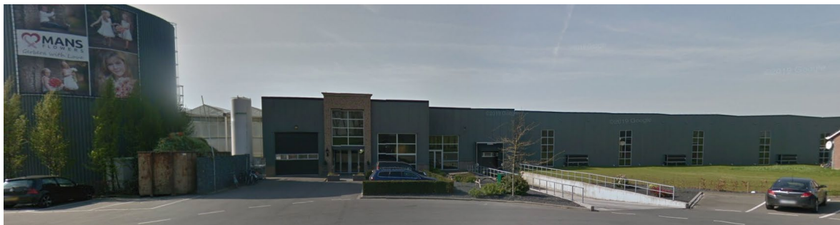
Omgeving projectgebied, bestaand glastuinbouwbedrijf Liesveldsesteeg 28a, bedrijfsgebouw en technische installaties
