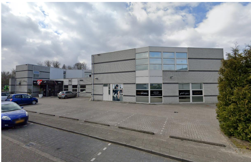
Figuur 4: Aanzicht van De Bleekvelden 24-26 gezien vanaf De Bleekvelden
