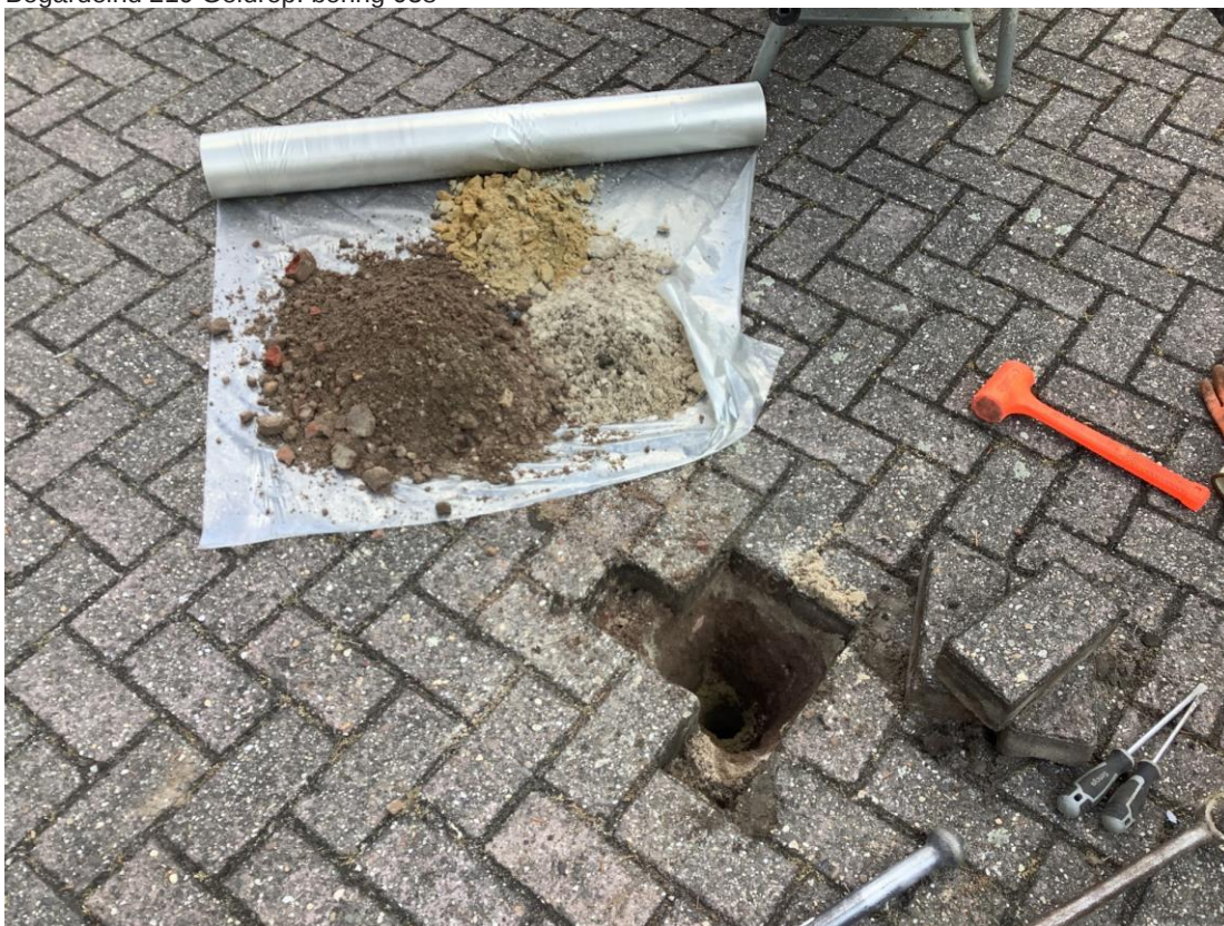
Bogardeind 219 Geldrop: boring 039
