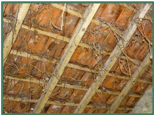
Niet onderschoten dak van de kippenshuur
