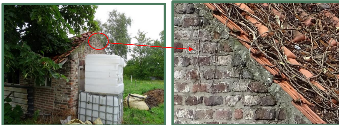
Dichtgemetselde kopgevelpannen
