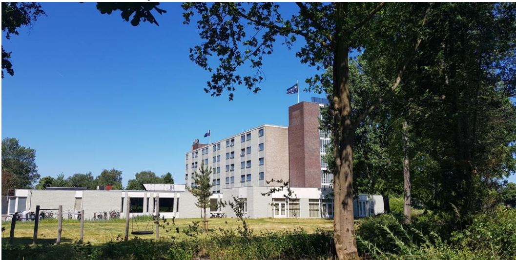
Foto 3. Situatie oostelijk van het gebouw. Dit is recent ingericht
