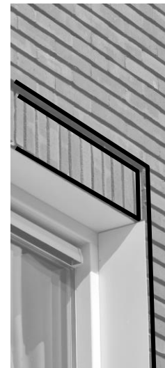
Detailering zoals verdiept metselwerk
