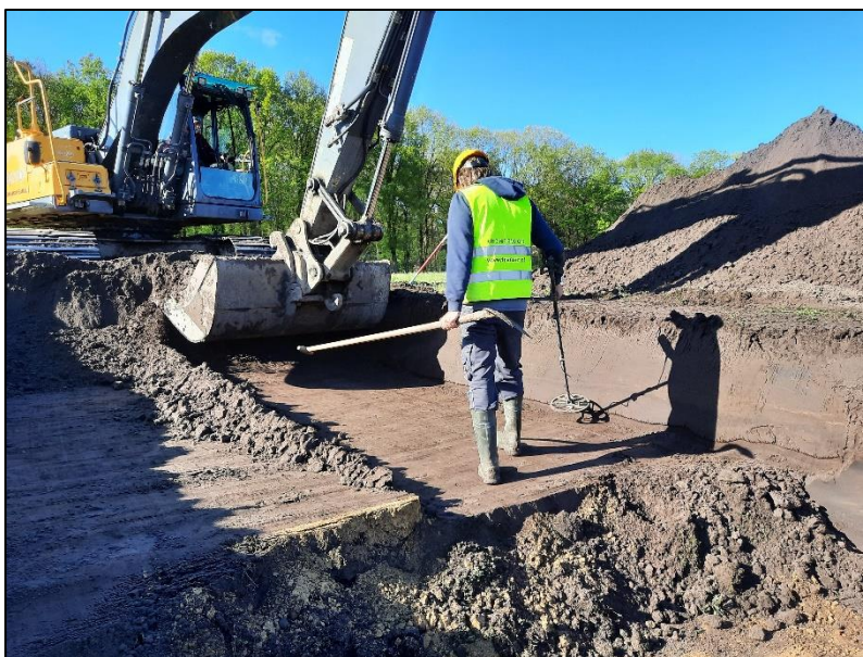
Figuur 4. De aanleg van een werkput.
