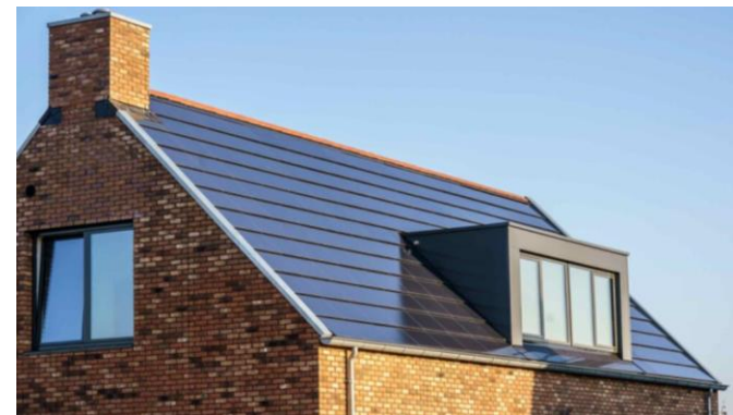
Geïntegreerde zonnepanelen
