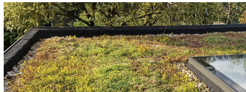
Groen dak met sedum
