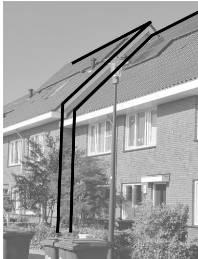
Verspringen van de voorgevel binnen een bouwblok met aaneengesloten rijwoningen
