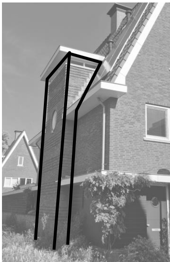
Een accent die vanuit de voorgevel, door de kap heen gaat
