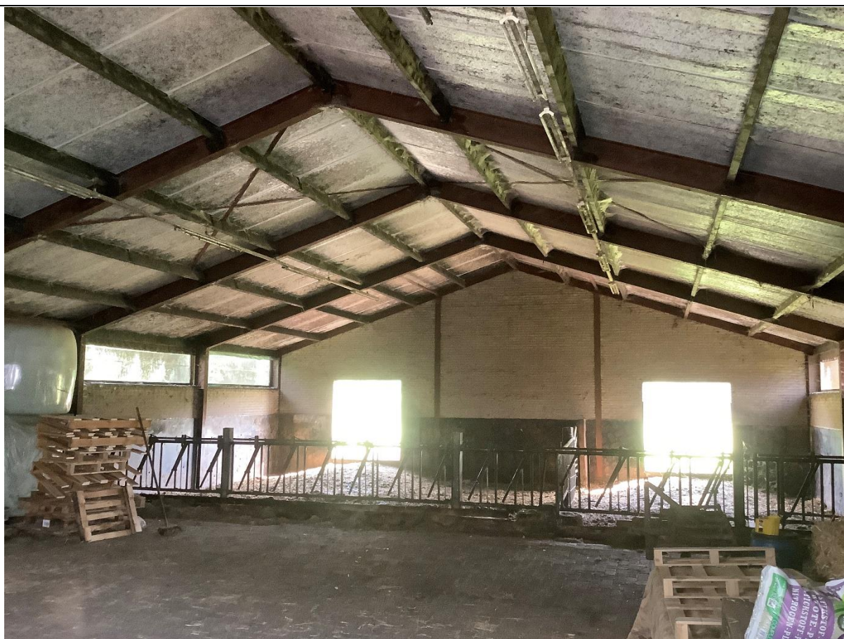
Foto 5: binnenzijde bestaande schuur
