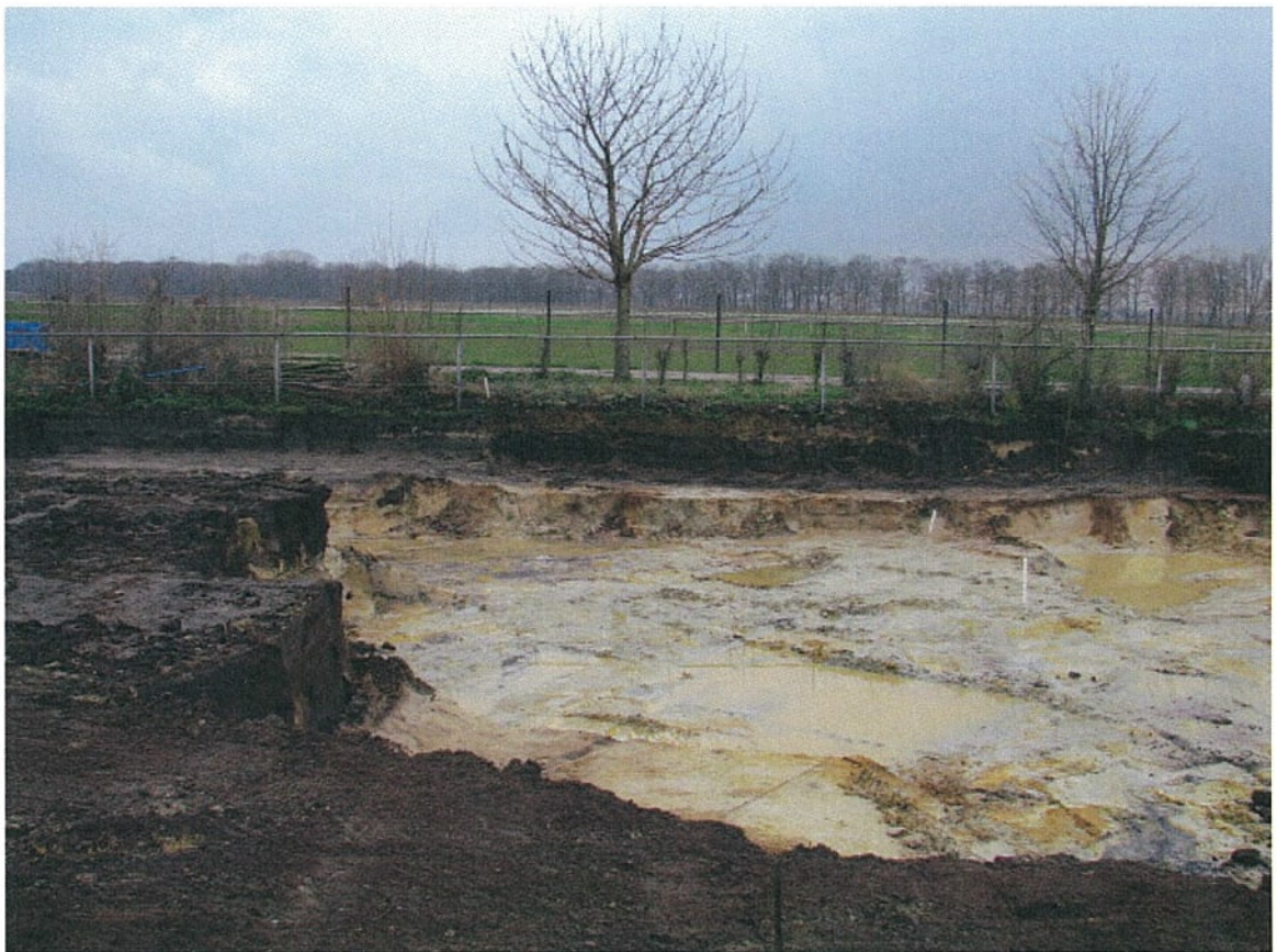
foto 3: ontgraving westzijde voormalig stortgat
