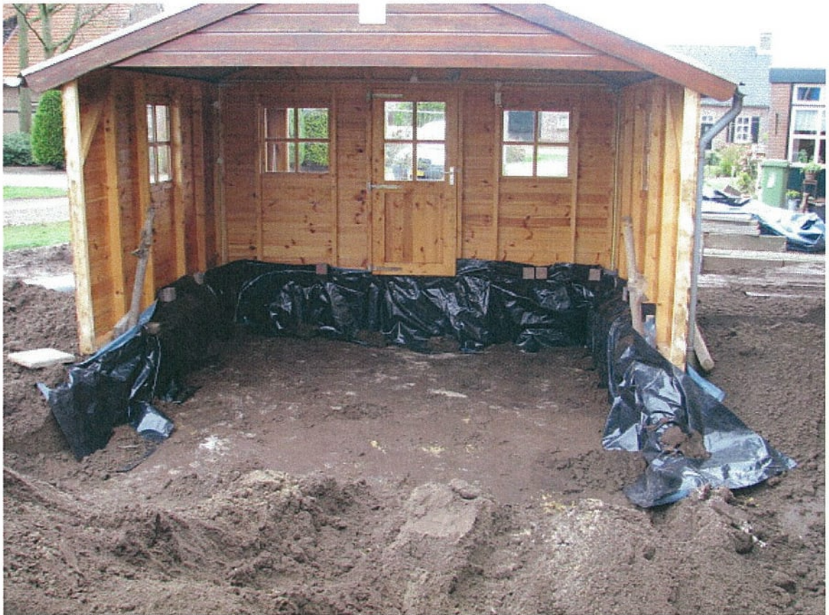
foto 1: in pandige ontgraving tuinhuisje noordzijde
