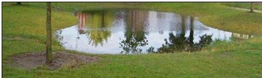
Figuur 14: voorbeeld infiltratielaagte
