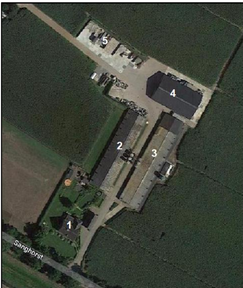
Afbeelding 3 Luchtfoto huidige situatie plangebied
