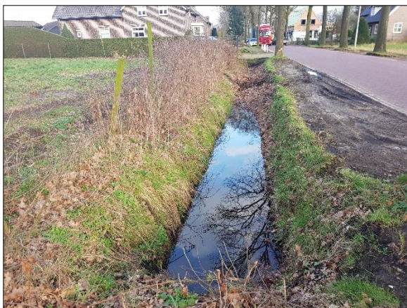
Figuur 8. Afwatersloot aan straatzijde
