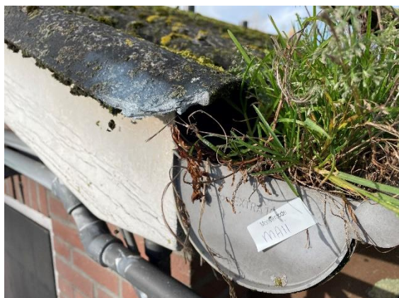
Monsternamelocatie MA11 (asbest niet aantoonbaar)
