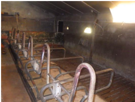
Overzicht binnenzijde (gierkelders niet onderzocht)
