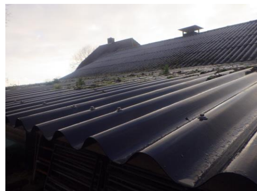
Aanbouw heeft pvc platen
