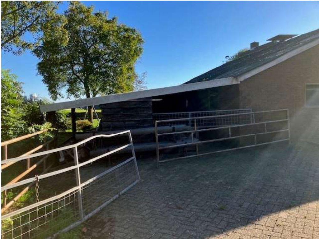
• Afbeelding 6: Aanbouw aan ligboxenstal wordt gesloopt
