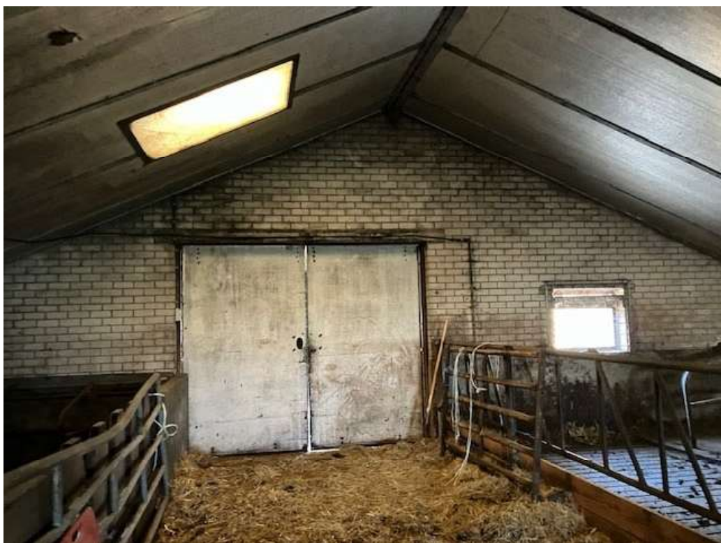
• Afbeelding 9: binnenzijde stal, wordt gesloopt
