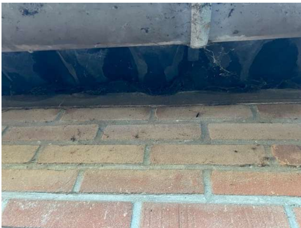
• Afbeelding 33: onderzijde dak dicht gemaakt
