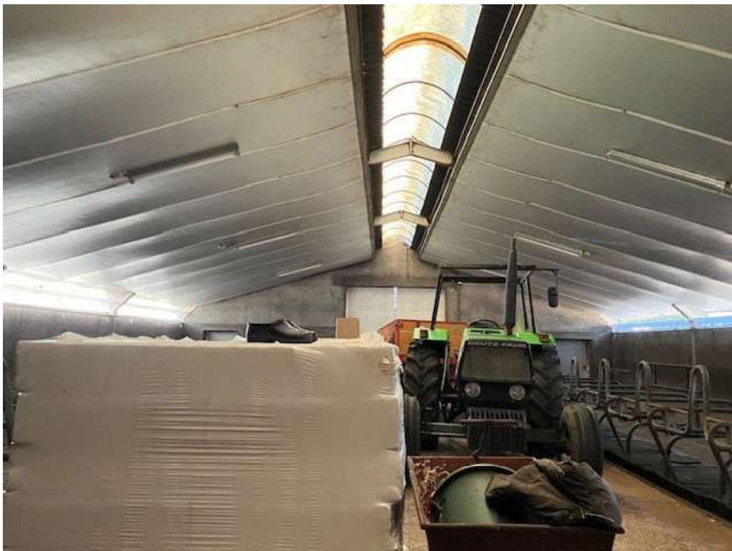
• Afbeelding 7: binnenzijde leegstaande ligboxenstal, blijft behouden
