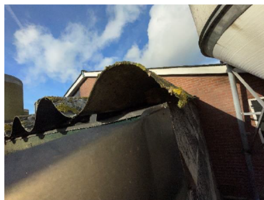
Bitumen golfplaten op aanbouw niet verdacht
