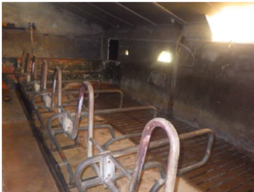
Overzicht binnenzijde (gierkelders niet onderzocht)
