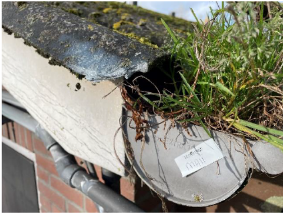
Monsternamelocatie MA11 (asbest niet aantoonbaar)
