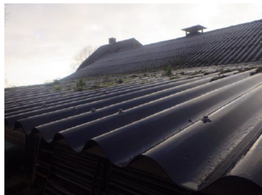
Aanbouw heeft pvc platen
