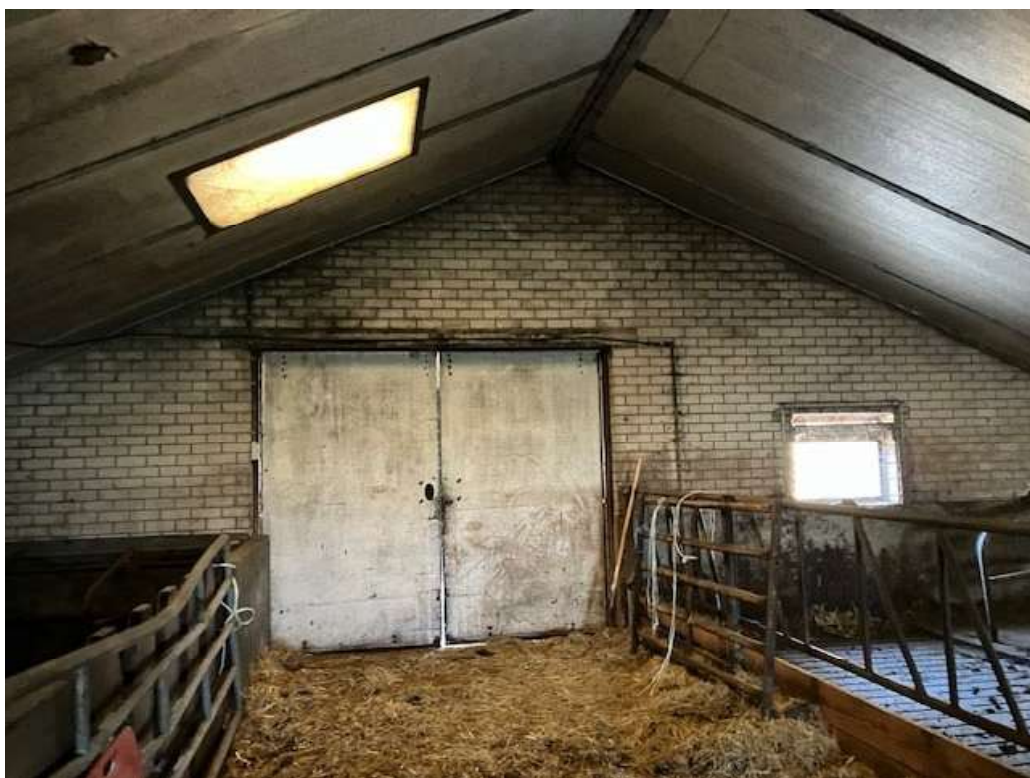
• Afbeelding 9: binnenzijde stal, wordt gesloopt
