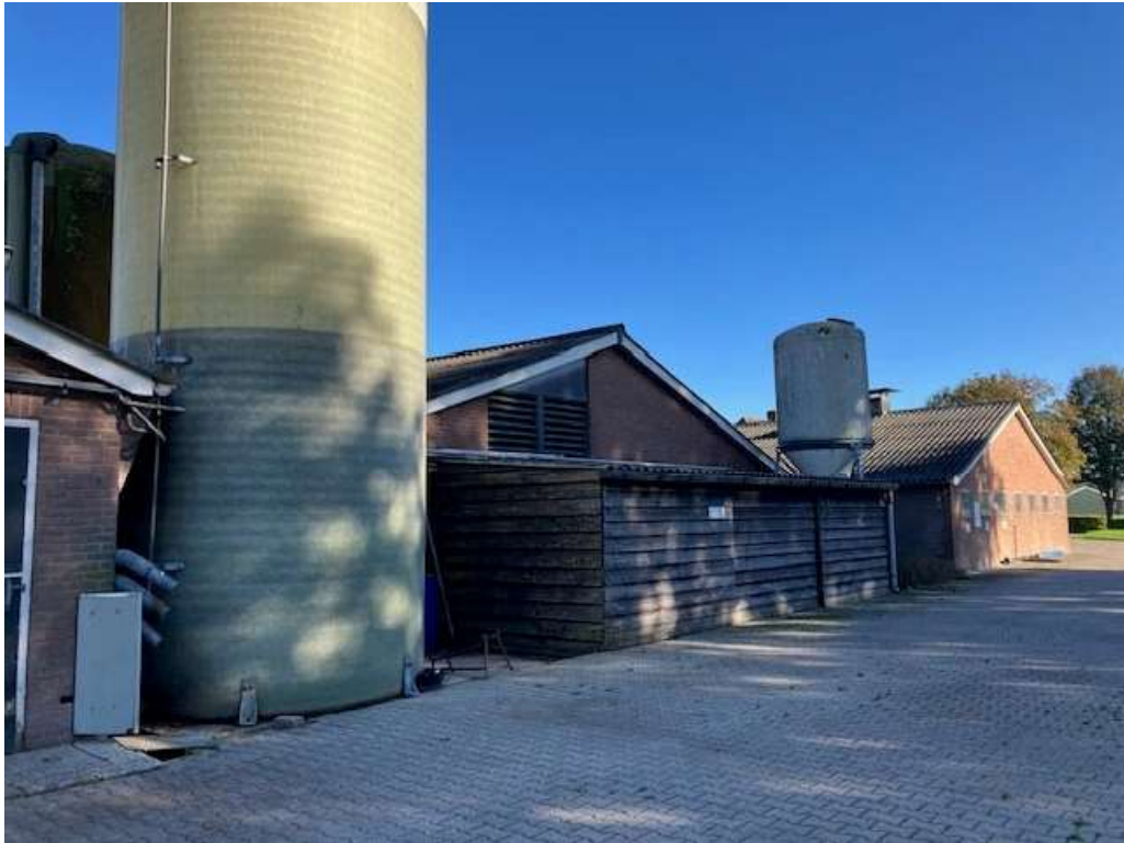
• Afbeelding 31: voorgevel te slopen stallen met aansluitend erf
