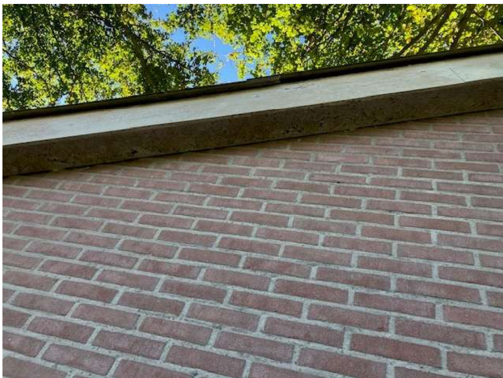
• Afbeelding 18: Onderzijde dakrand sluit zeer goed aan
