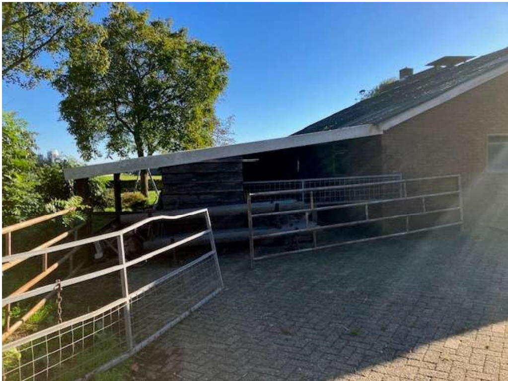
• Afbeelding 6: Aanbouw aan ligboxenstal wordt gesloopt
