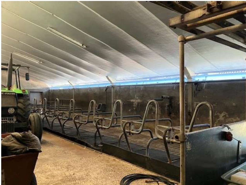
• Afbeelding 8: binnenzijde leegstaande ligboxenstal, blijft behouden
