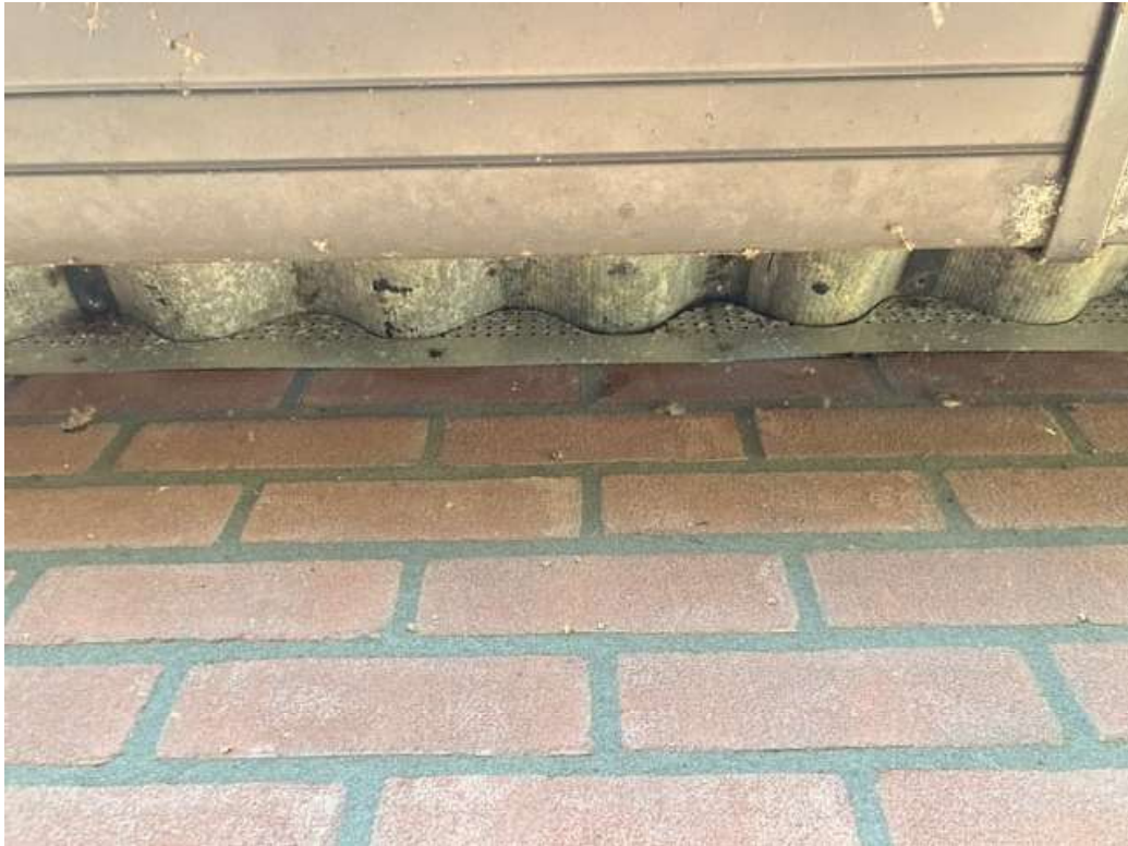
• Afbeelding 24: Onderzijde dak, aansluiting op de gevel dicht gemaakt
