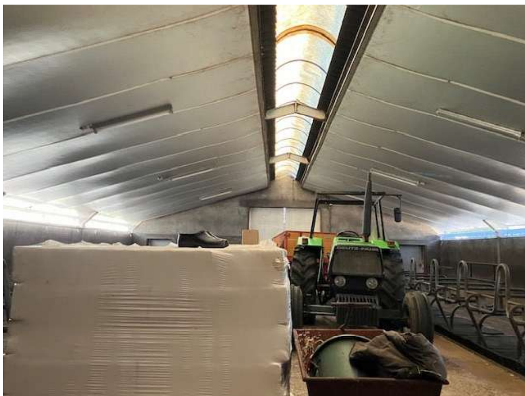
• Afbeelding 7: binnenzijde leegstaande ligboxenstal, blijft behouden
