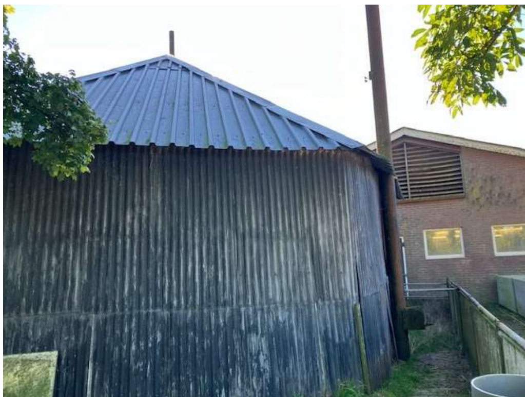
• Afbeelding 20: Hooimijt wordt gesloopt en zicht op achtergevel varkensstal
