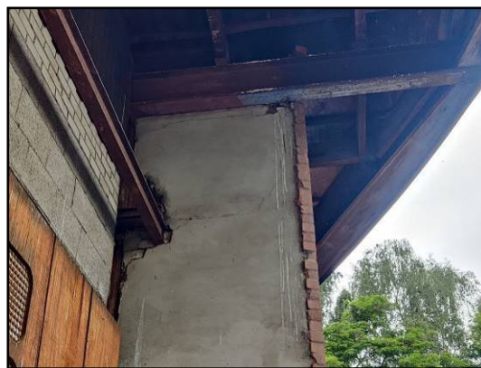
Afbeelding 6: Meststrepen op gevel
