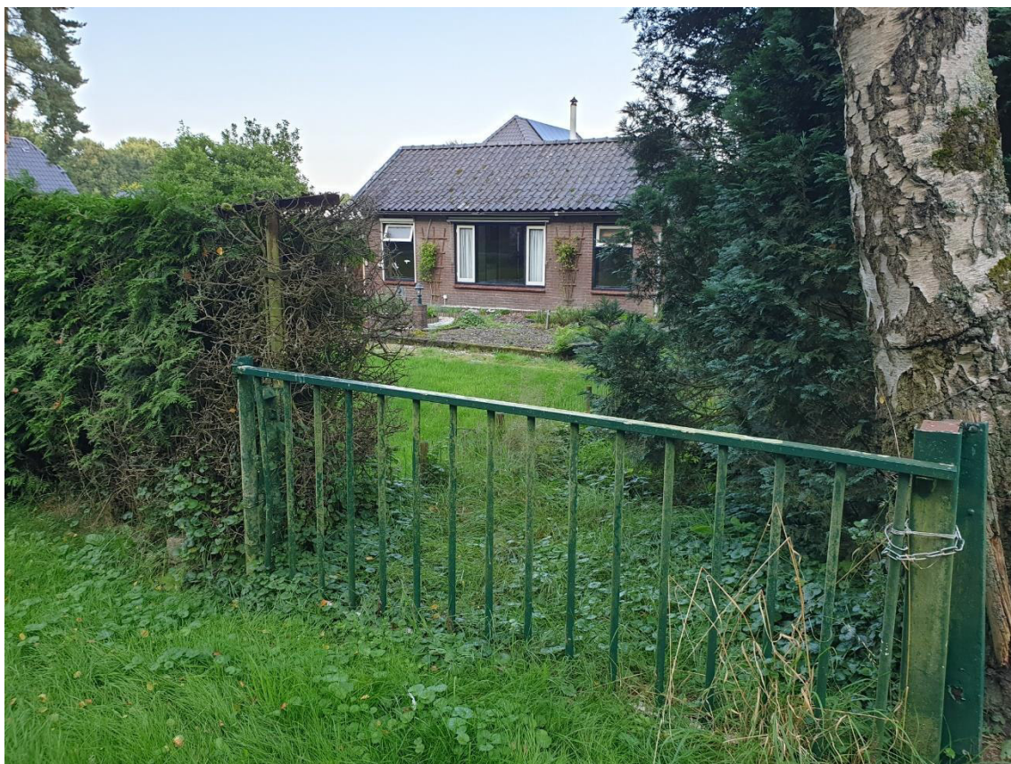
Afbeelding 4: Verouderde te slopen woning Parallelweg 8.
