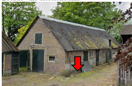
Locatie v.m. dieselolietank:
