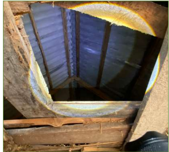
Afb. 2.7 en 2.8 - Ook de varkensschuur heeft een enkel golfplaten dak. De muren van de schuren en stallen hebben geen spouw; ook hier zijn verblijfplaatsen van vleermuizen uitgesloten.
