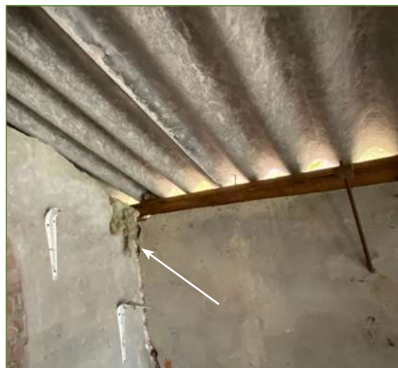
Afb. 2.13 en 2.14 - De scheur in de kippenschuur komt uit aan de binnenzijde. Door gebrek aan spouwruimte zijn hier geen mogelijkheden voor vleermuizen.
