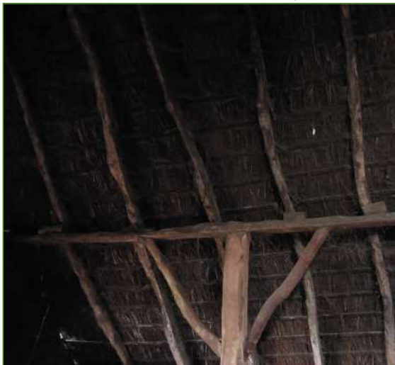
Afb. 2.3 en 2.4 - De rieten kap van de boerderij is aan de binnenzijde niet afgetimmerd en is sluitend aan de buitenzijde; er zijn geen beschutte ruimtes beschikbaar voor verblijven voor huismus en/of vleermuizen.
