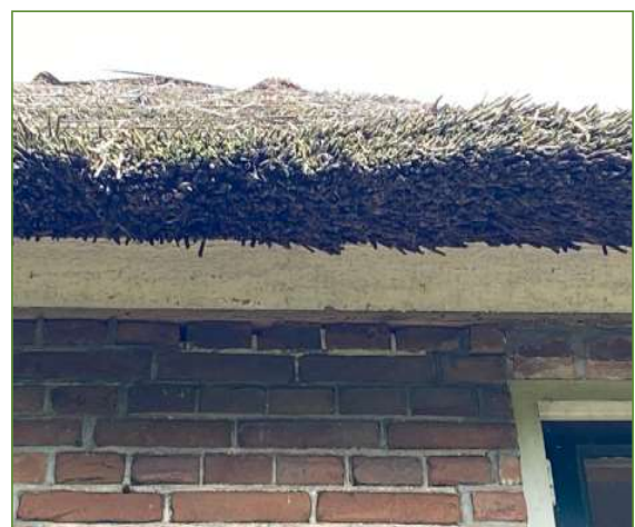
Afb. 2.11 en 2.12 - Aan de voorzijde van de boerderij zitten openingen groot genoeg voor vleermuizen om toegang te geven tot besloten ruimtes achter de boeiboorden (witte pijlen). Aan de zijkanten en achterkant sluit het houtwerk strak aan op de kap en de muren.
