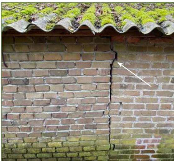
Afb. 2.13 en 2.14 - De scheur in de kippenschuur komt uit aan de binnenzijde. Door gebrek aan spouwruimte zijn hier geen mogelijkheden voor vleermuizen.
