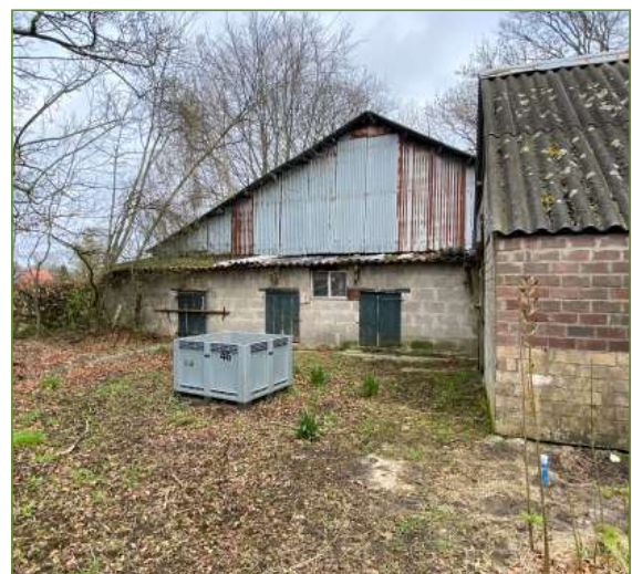
Afb. 1.8 - Achter de varkens- en koeienstal
