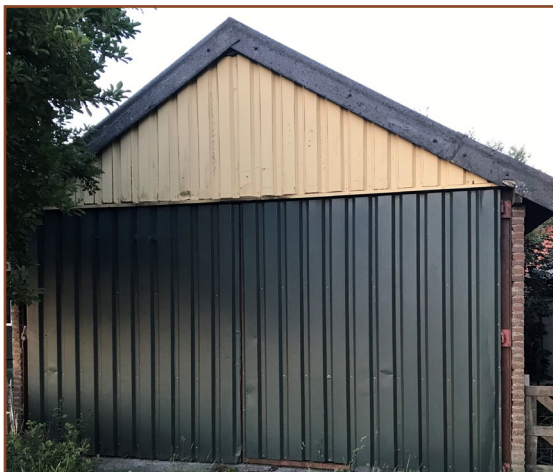
Afb. 2.2: Het te slopen bijgebouw/garage is ongeschikt voor vleermuizen en andere beschermde soorten om te dienen als vaste rust- en verblijfplaats.
