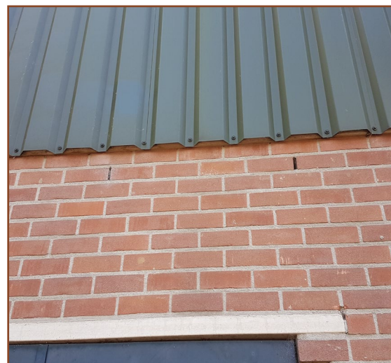
Afb. 2.5: Door de open stootvoegen kunnen vleermuizen de spouw van de oude veeschuur bereiken en gebruiken als vaste rust- en verblijfplaats. Nader onderzoek moet uitsluiten of de veeschuur daadwerkelijk in gebruik is door vleermuizen.
