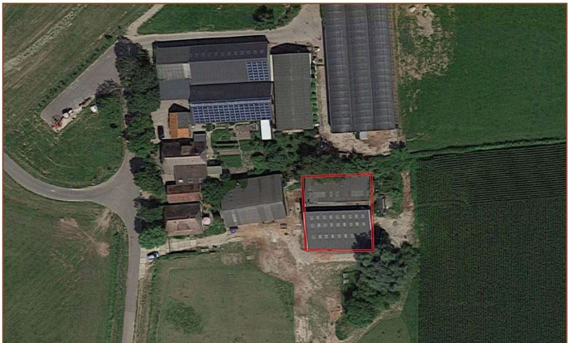
Afb. 1.1: Luchtfoto van de projectlocatie aan de Stege 10 te Veessen met de te onderzoeken bebouwing (rood kader). Bron: GoogleMaps
