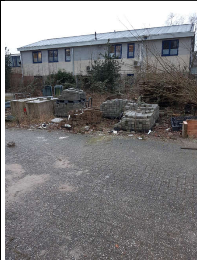
Deellocatie J: Voormalige ondergrondse tanks
