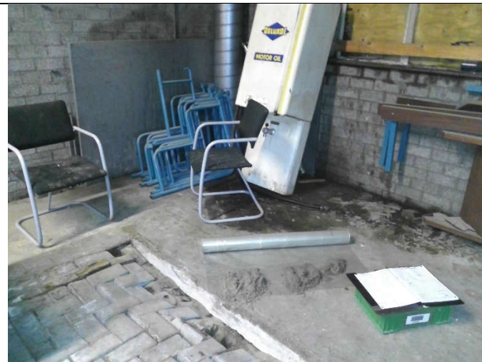
Boring 25 ter plaatse van de werkplaats (deellocatie E)
