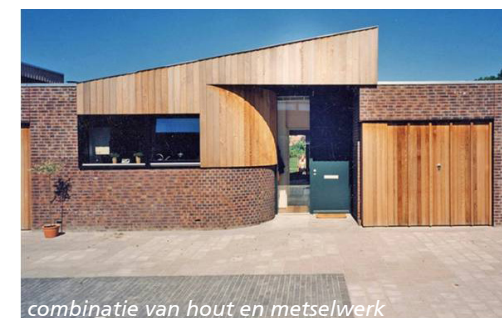
combinatie van hout en metselwerk
