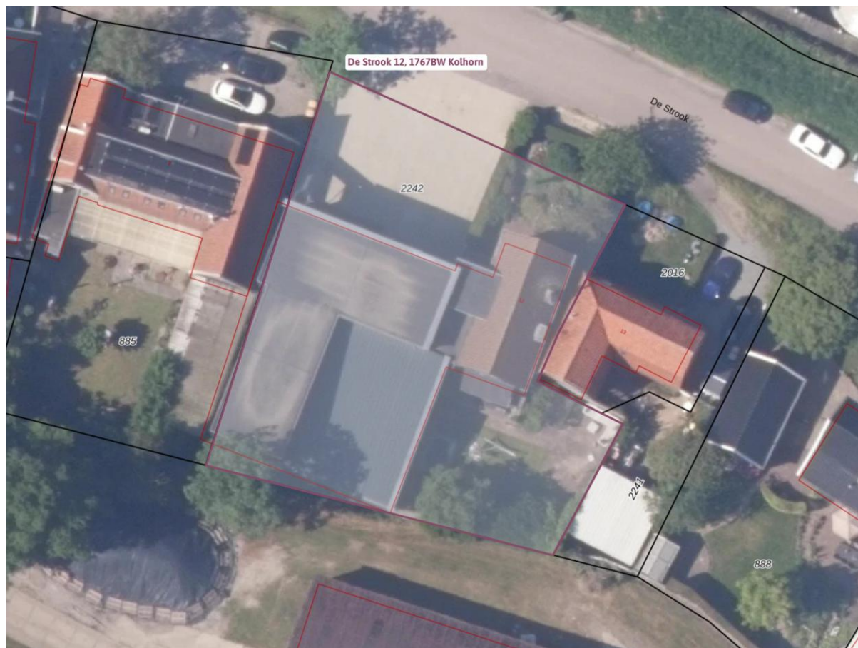
Afbeelding 3 Luchtfoto bestaande situatie
