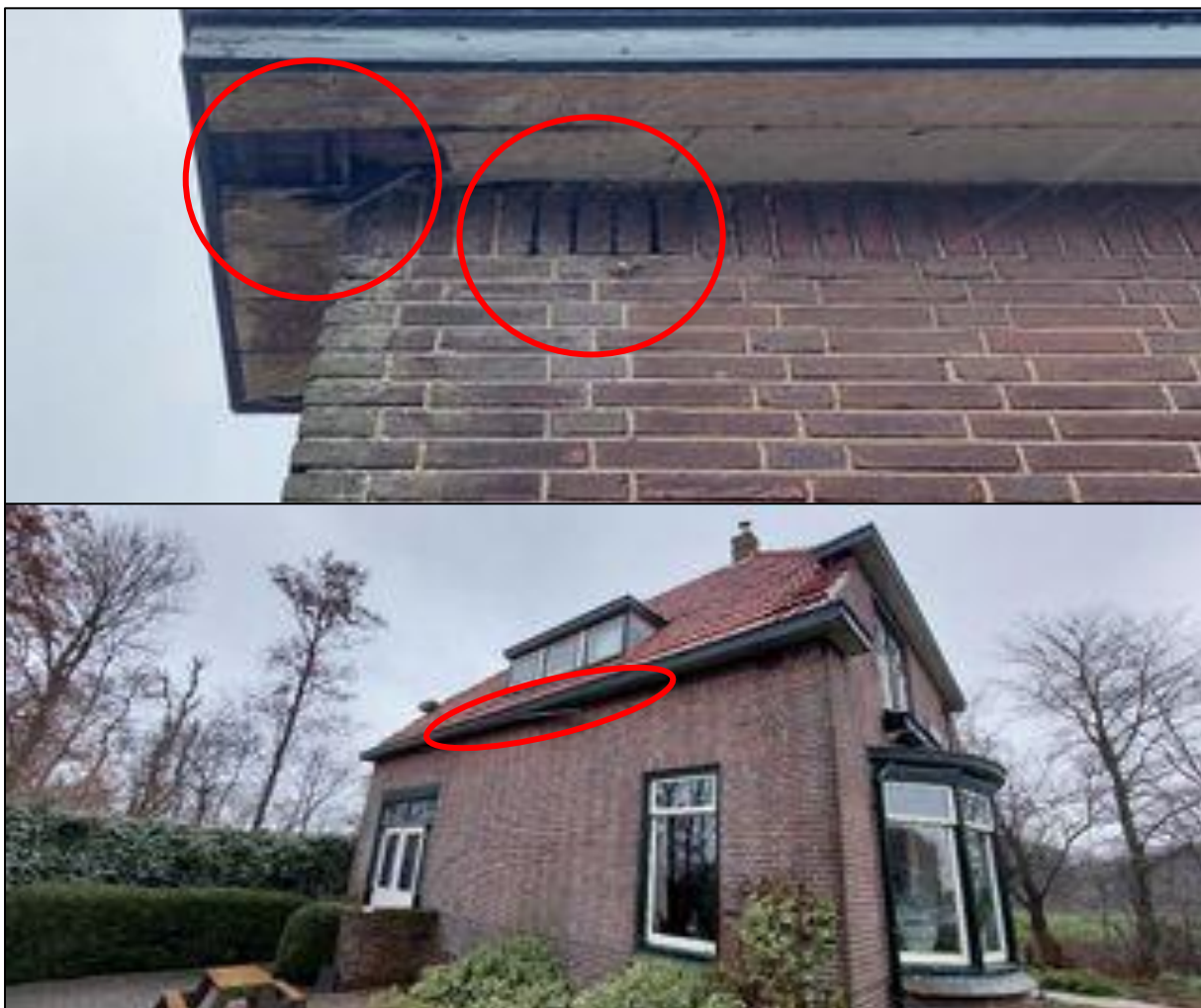
Figuur 4 | Spleten, gaten en ventilatioeroosters die toegang geven tot potentiële verblijfplaatsen (rode kaders).
