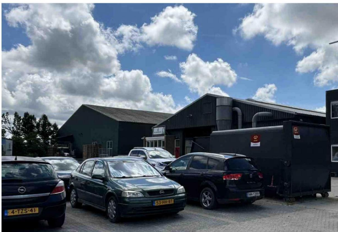
Afb. 5: Voorkant van bedrijfspanden waar golfplaten dak en gevel structuur te zien is.
