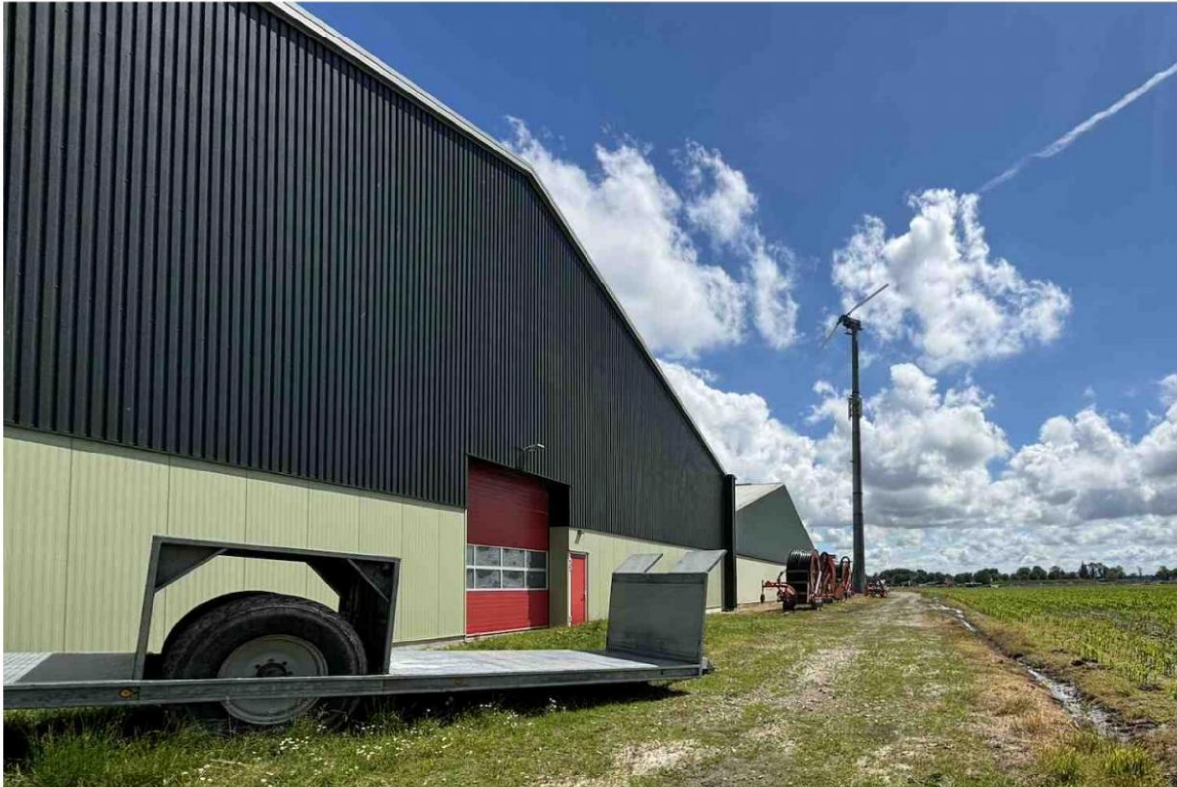
Afb. 6: Achterkant van het pand waarop gevelstructuur is te zien.
