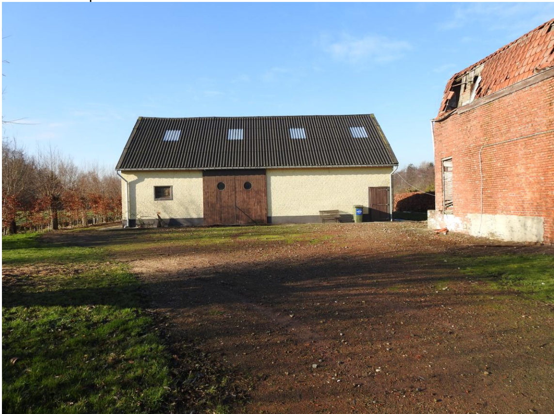
Foto 5. Te slopen schuur.
