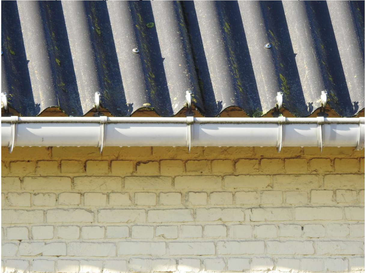
Foto 6. Te slopen schuur (geen mogelijkheden voor mussen en vleermuizen).
