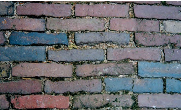
gebakken klinker halfsteens verband
