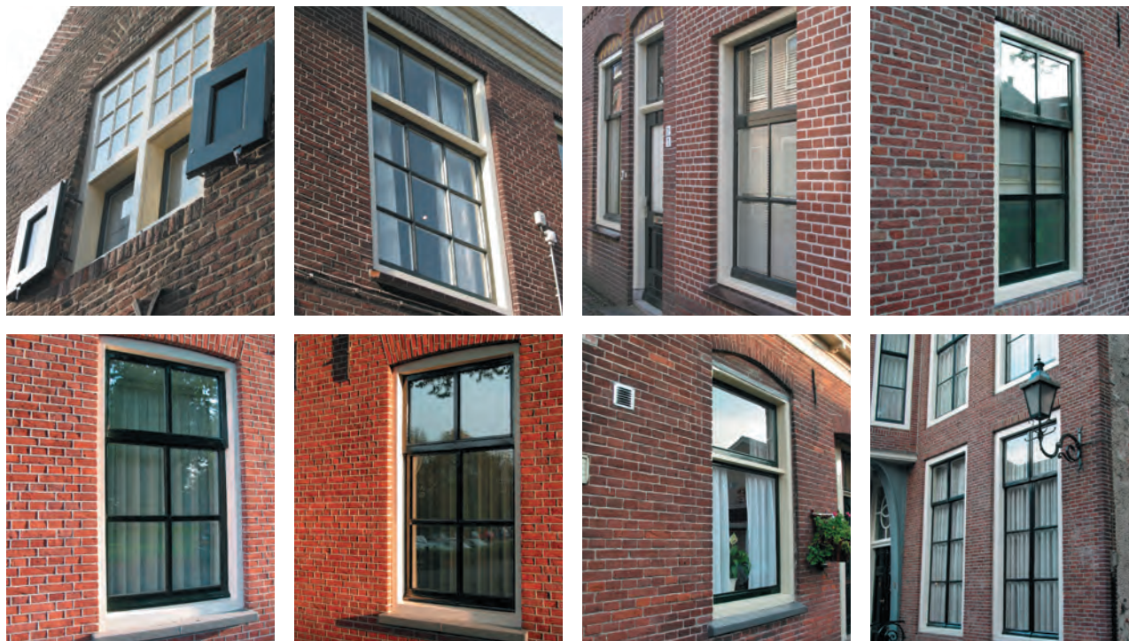
De ramen van de binnenstad. De kozijnen van de panden zijn van hout en zijn terugliggend met een diepe neg waardoor er reliëf en schaduwwerking in het gevelvlak ontstaat.
