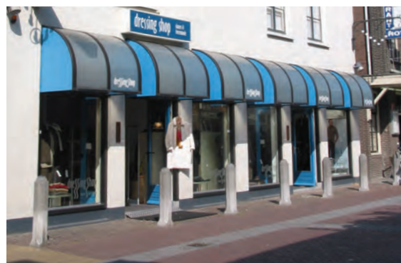
zonwering niet passend bij de architectuur van het pand
