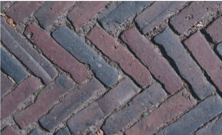
gebakken klinker keper verband
