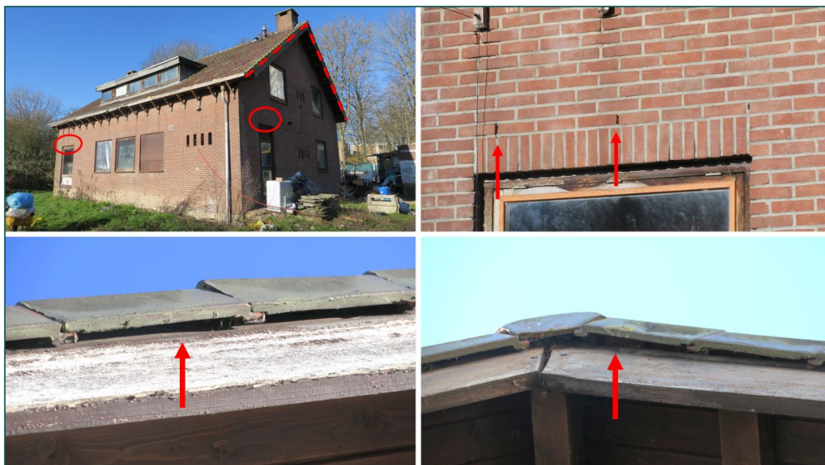
Figuur 3.3 De te slopen woning (1) heeft potentie voor de aanwezigheid van vleermuisverblijfplaatsen. De spouw en open dakruimte zijn toegankelijk middels open stootvoegen en kieren achter de kantpannen, respectievelijk. De foto's weergeven een impressie van de potentiële in- en uitvliegopeningen.
