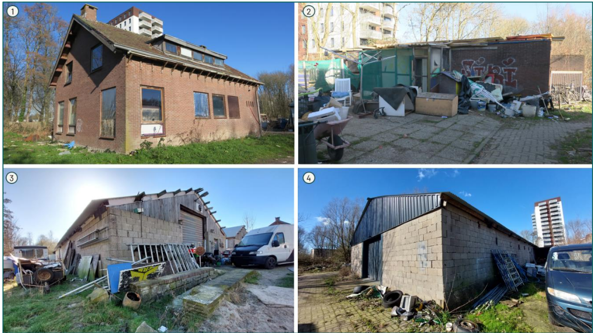
Figuur 1.3 Op de planlocatie is men voornemens om de volgende gebouwen te slopen: 1) woning, 2) bijgebouw, 3) noordelijk gelegen bedrijfsloods en 4) zuidelijk gelegen bedrijfsloods.
