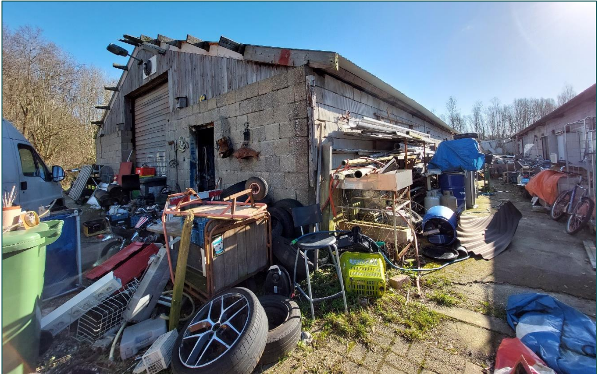
Figuur 3 Impressie van de noordelijk gelegen bedrijfsloods (gebouw 3) en de directe omgeving hiervan. Op het terrein zijn voldoende wegkruipmogelijkheden voor o.a. grondgebonden zoogdieren.
