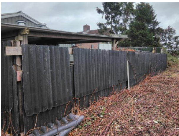
Figuur 8: golfplaten schutting achter loods Hoogland 12
