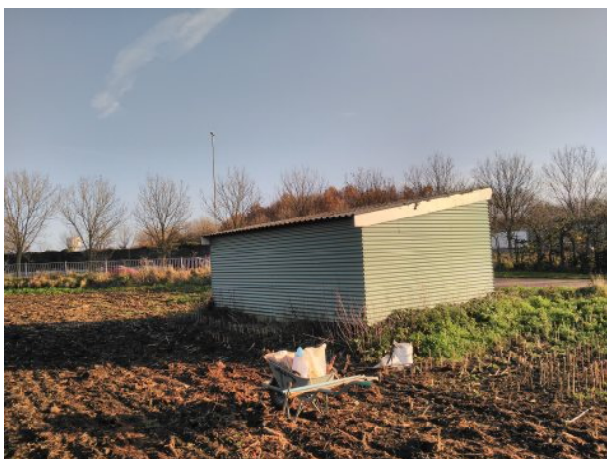
Figuur 6: opstal voorzijde terrein Hoogland 14
