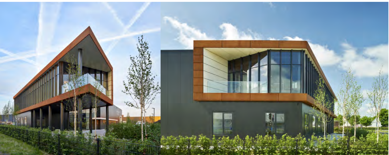
Subtiel accent op de hoek van de N210 en Lage Dijk-Noord
