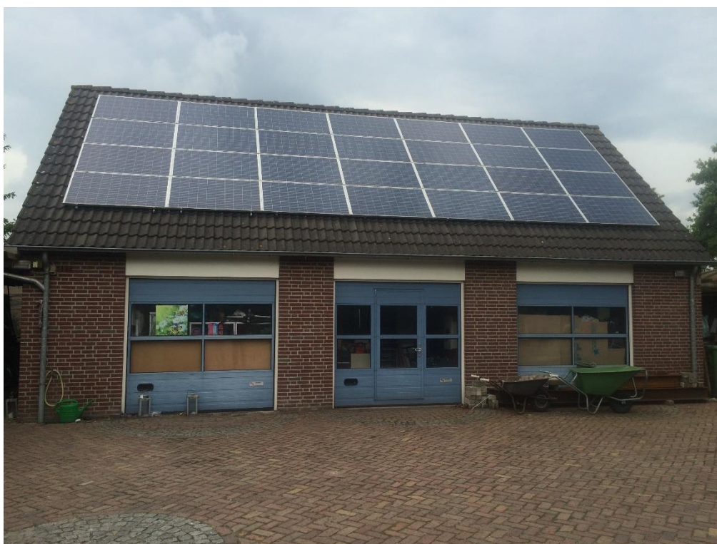
Bijgebouw behorende tot bedrijfswoning Hoogheistraat 6a
