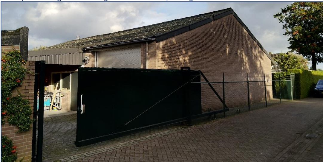
Te slopen bedrijfsbebouwing aan insteek Kapelweg
