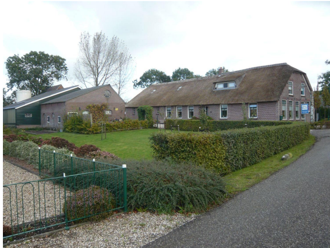
Afb. 4 De boerderij, gezien vanuit het zuidwesten. Links op de foto is de schuur-wagenberging zichtbaar. Door verbouwingen en herstel na stormschade is de oorspronkelijke schuur vrijwel onherkenbaar.
