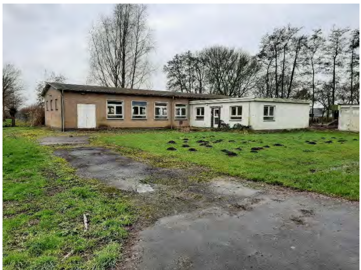
Foto 3: werkplaatsen en spuitrij
