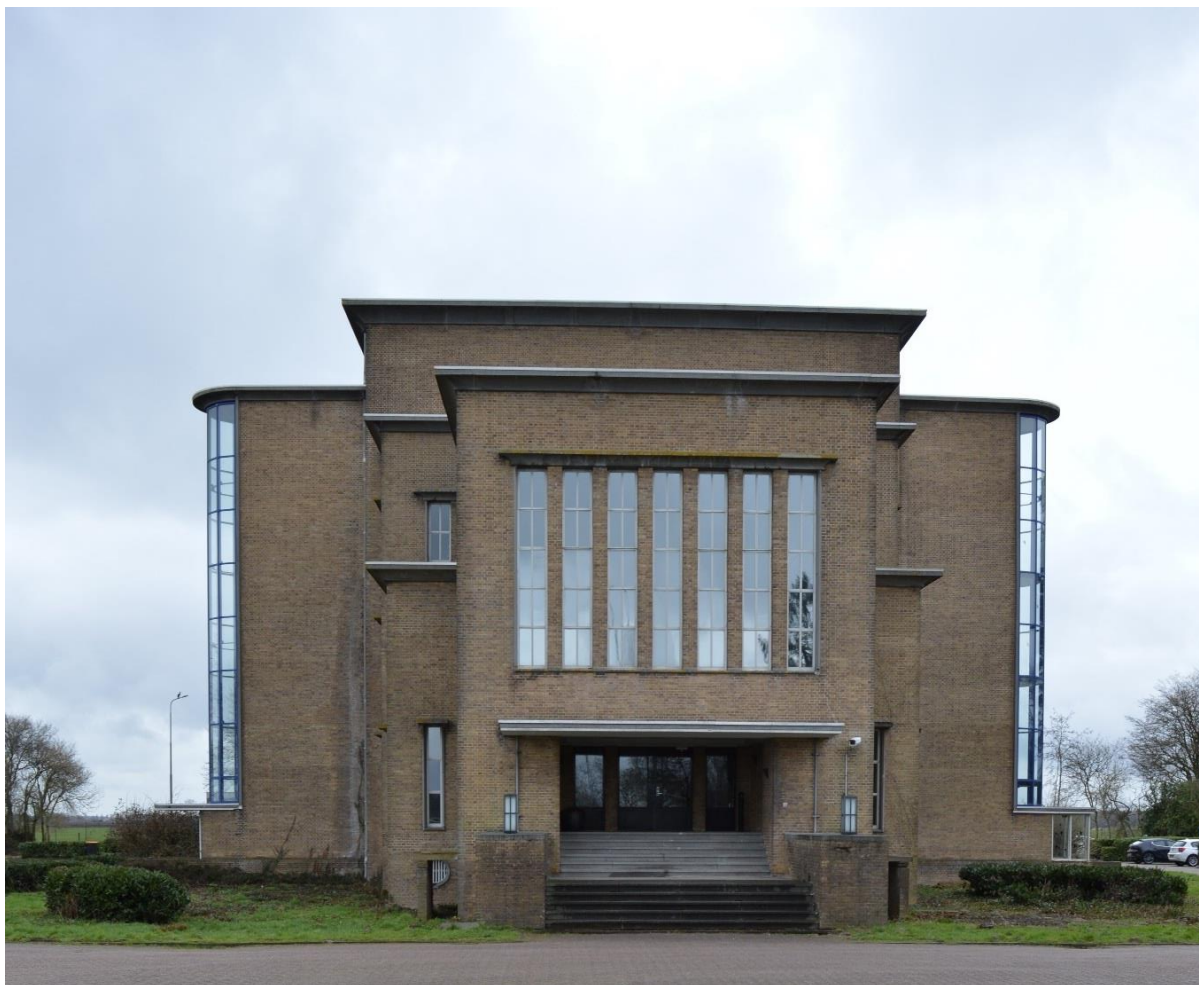
De voorgevel van het voorgebouw, gezien vanaf het voorterrein. Achter het voorgebouw staat het hogere kerngebouw, geflankeerd door de manifeste lift- en trappenhuizen aan weerszijden.
