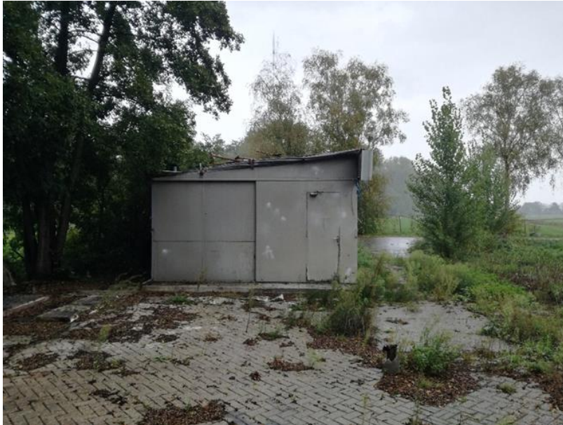
Golfplaten garage die in eerder onderzoek nog niet was meegenomen. (M. van Leeuwen, 7 oktober 2020)
