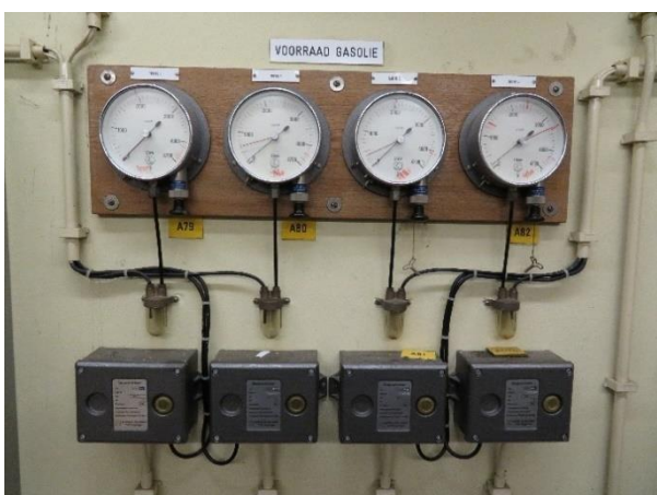
Links : inhoudsmeters voor de vier olietanks in de NSA-ruimte.
