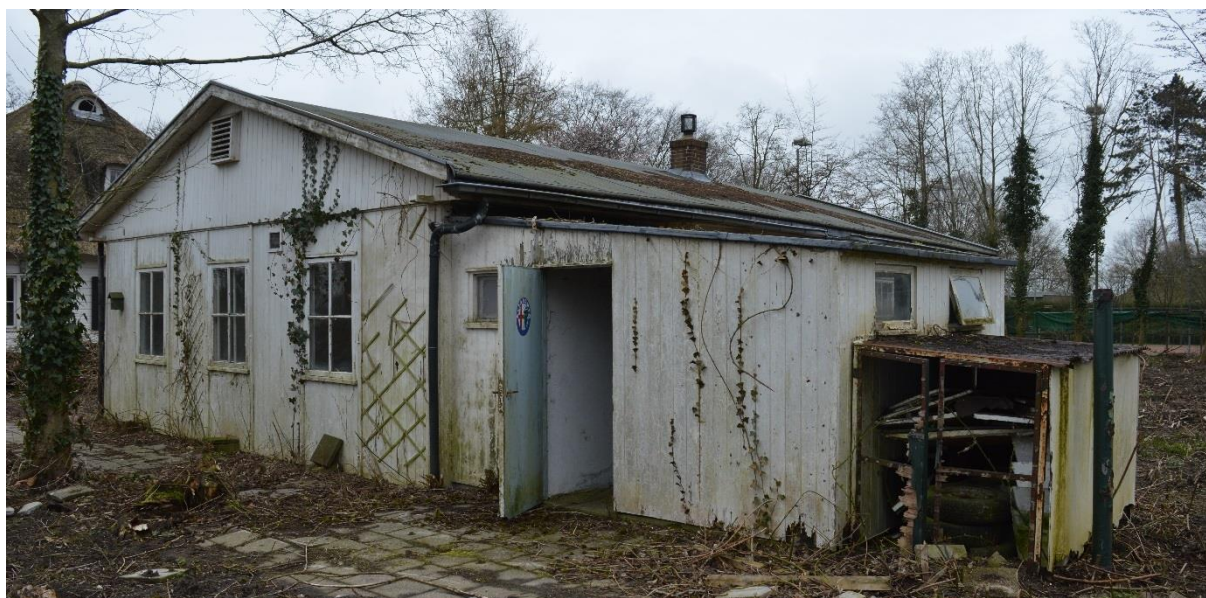
De secundaire aanbouwen tegen de noordgevel.
