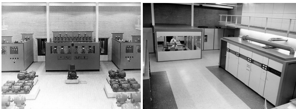
De machinezaal voorafgaande en na de vernieuwing van de installaties in het midden van de jaren zestig (Lof en Simonse 2011, pag. 211 en 207).
