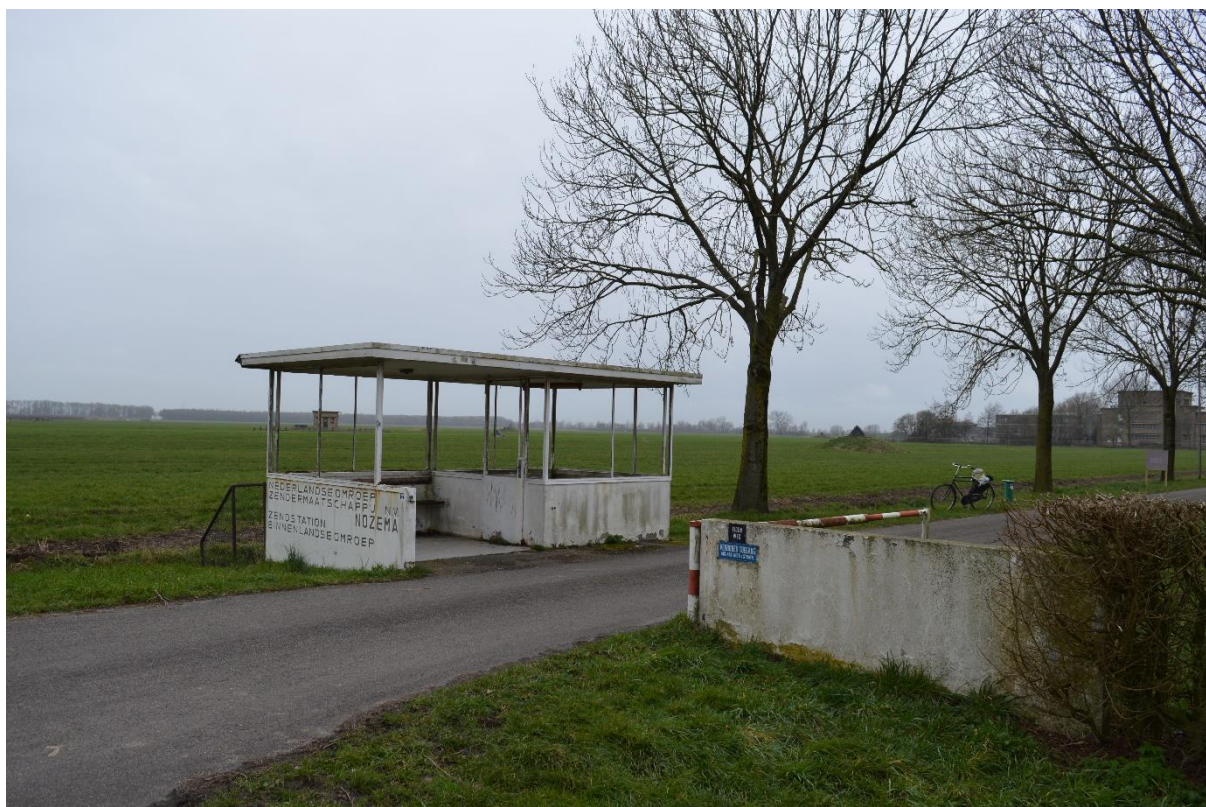
Vooraanzicht van het wachthuisje bij de entree van het zendercomplex.
