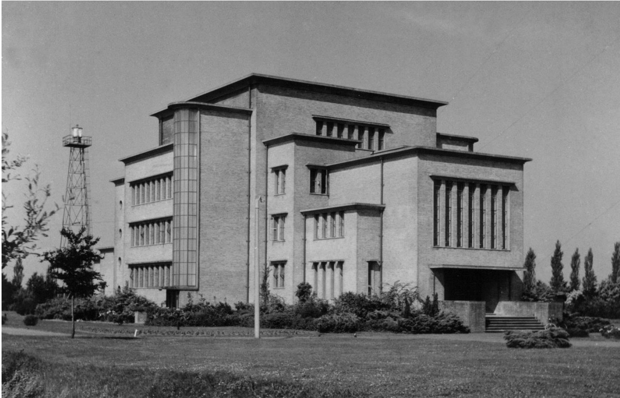
Het zendergebouw omstreeks 1950 (Archief Omroep Zender Museum, Map005_00007A). Op de achtergrond is een stalen mast op het achterterrein te zien, een lichttoren.
