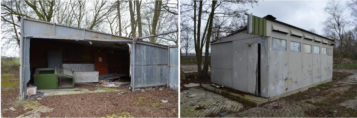
Links: een stalen opslagloods achter de werkplaats.
