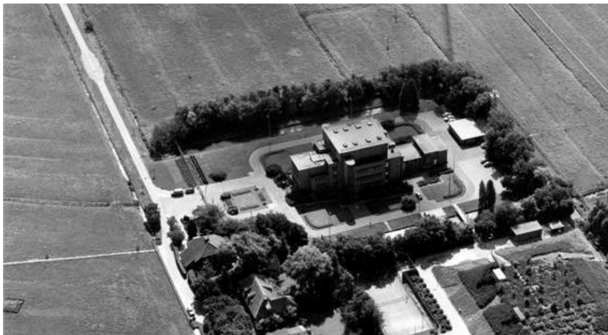
Luchtfoto van het zendercomplex en de bunker, circa 1980 (LPK-BO.ALG.AM.0001.G001). Op deze foto is de entree reeds gewijzigd door demping van een deel van de sloot en herziening van de beplanting aan de voorzijde van het terrein.
