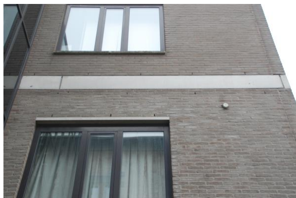
Afbeelding: open stootvoegen die kunnen dienen als invliegopening voor vleermuizen.
