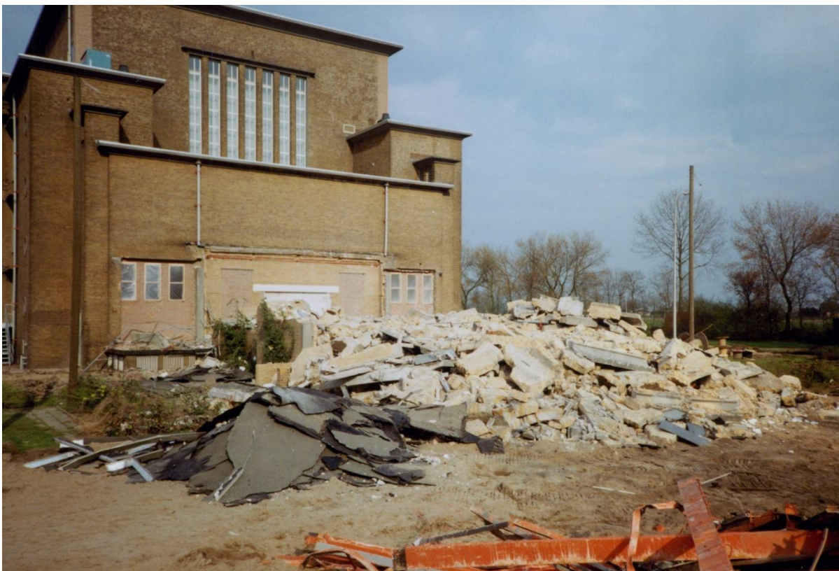
De achtergevel van het hoofdgebouw, na de sloop van het transformatorgebouw aan de achterzijde in 1991 (Archief Omroep Zender Museum, Map007_00007A). Op de begane grond tekenen zich de binnenwanden af in afwijkende steen. Deze gedeelten zijn bij de renovatie nieuw ingeboet in meer bijpassende steen.
