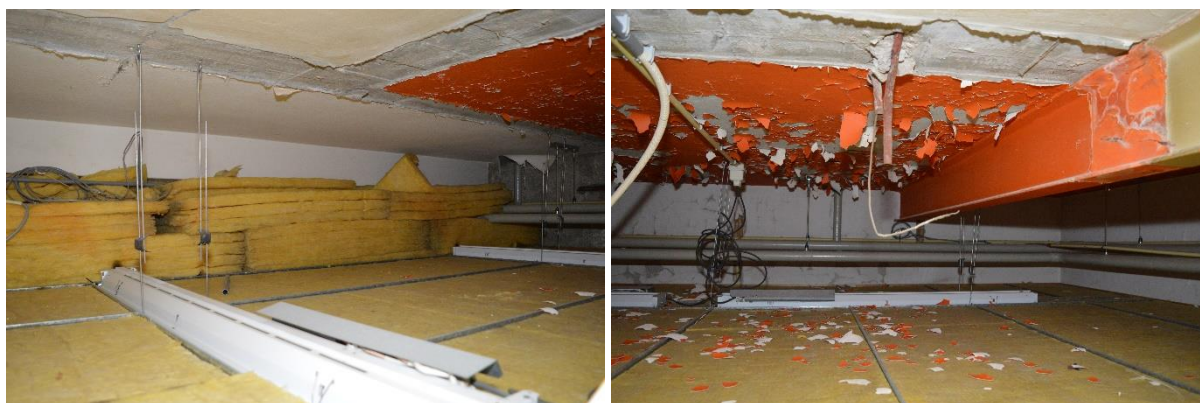
Boven de verlaagde plafonds van de bovenste ruimten van de noordelijke zijbeuk van de machinezaal zijn de aftekeningen van de oude indeling te herkennen. De ruimten hadden een geschuurde afwerking. Deze ontbreekt ter plaatse van de oude tussenwanden.
