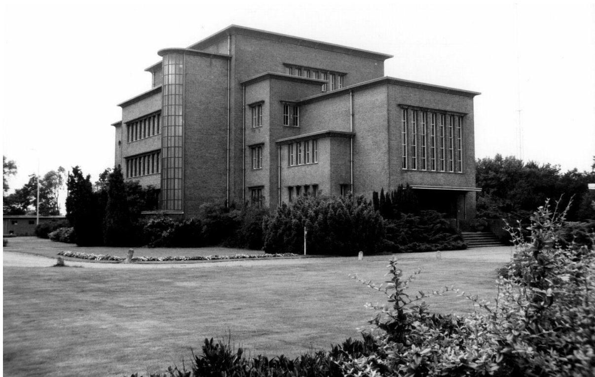
Het zendergebouw in 1981, foto P. Nijhof (Het Utrechts Archief, nr. 25408). De tuinaanleg is niet gewijzigd sinds 1939, afgezien de herinrichting van de entree en het achterterrein (niet zichtbaar op deze foto) Herkenbaar grasperken, smalle plantvakken langs de ringweg, bosschage-stroken langs het hoofdgebouw en de windsingels.
