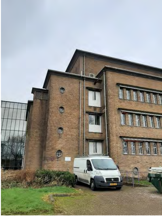
Foto's 42 en 43: ontluchting buiten het pand van de voormalige bovengrondse dieseltank in NSA
