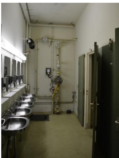
Links : overzicht van de sanitaire ruimte (ruimte 24) met rechts de douche- en toiletcabines (waarboven de watertanks) en links de roestvast stalen wasbakken.
