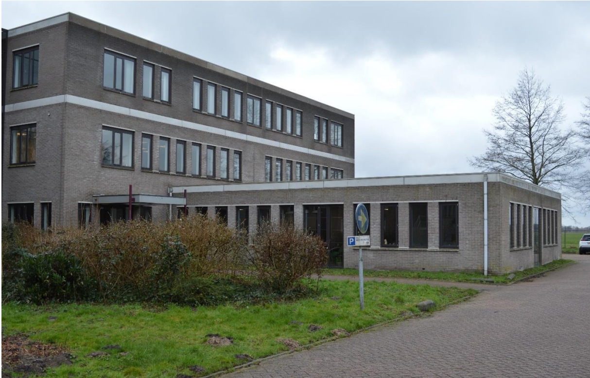
Het kantoor- en bedrijfsgebouw, gezien vanuit het noordoosten. Het drielaags gebouw is in twee fasen tot stand gekomen. De onderste twee bouwlagen dateren uit 1991-'92, de bovenste bouwlaag uit 1994.
