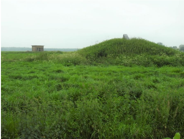
Versterkerhuisje en de betonnen ankerblokken van de oude tuikabels. (juni 2021, M.v. Leeuwen)
