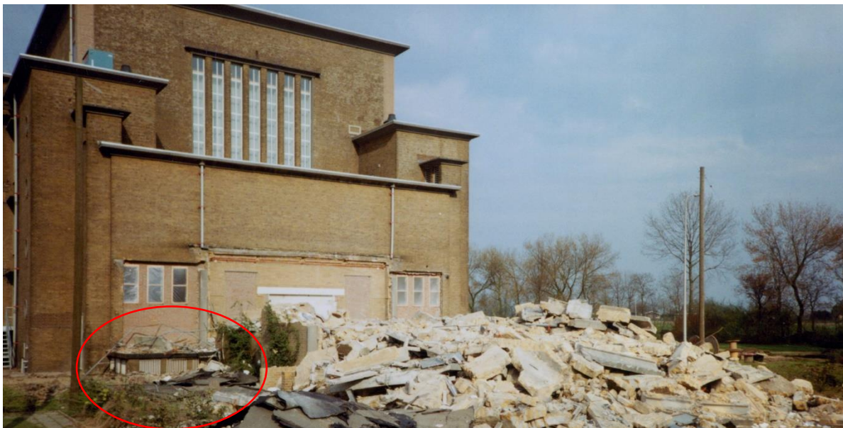
De achtergevel van het hoofdgebouw, na de sloop van het transformatorgebouw aan de achterzijde in 1991 (Archief Omroep Zender Museum, Map007_00007A). Op de begane grond bevindt zich een lage aanbouw met roosters, onderdeel van de luchtkoeling.
