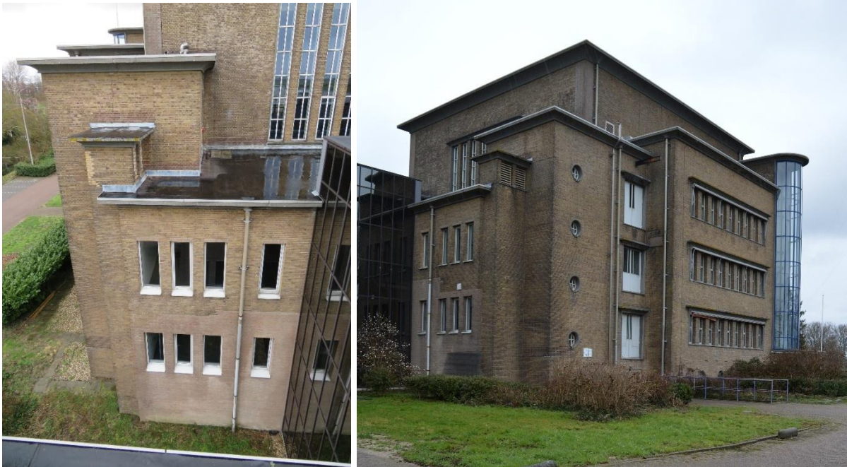
Links: het noordelijke deel van de achtergevel van de achterbouw. De begane grond van deze gevel is nieuw opgetrokken, inclusief de vensters. De vensters op de eerste verdieping zijn nieuw ingezaagd. Rechts: overhoeks overzicht van het hoofdgebouw, gezien vanuit het zuiden.
