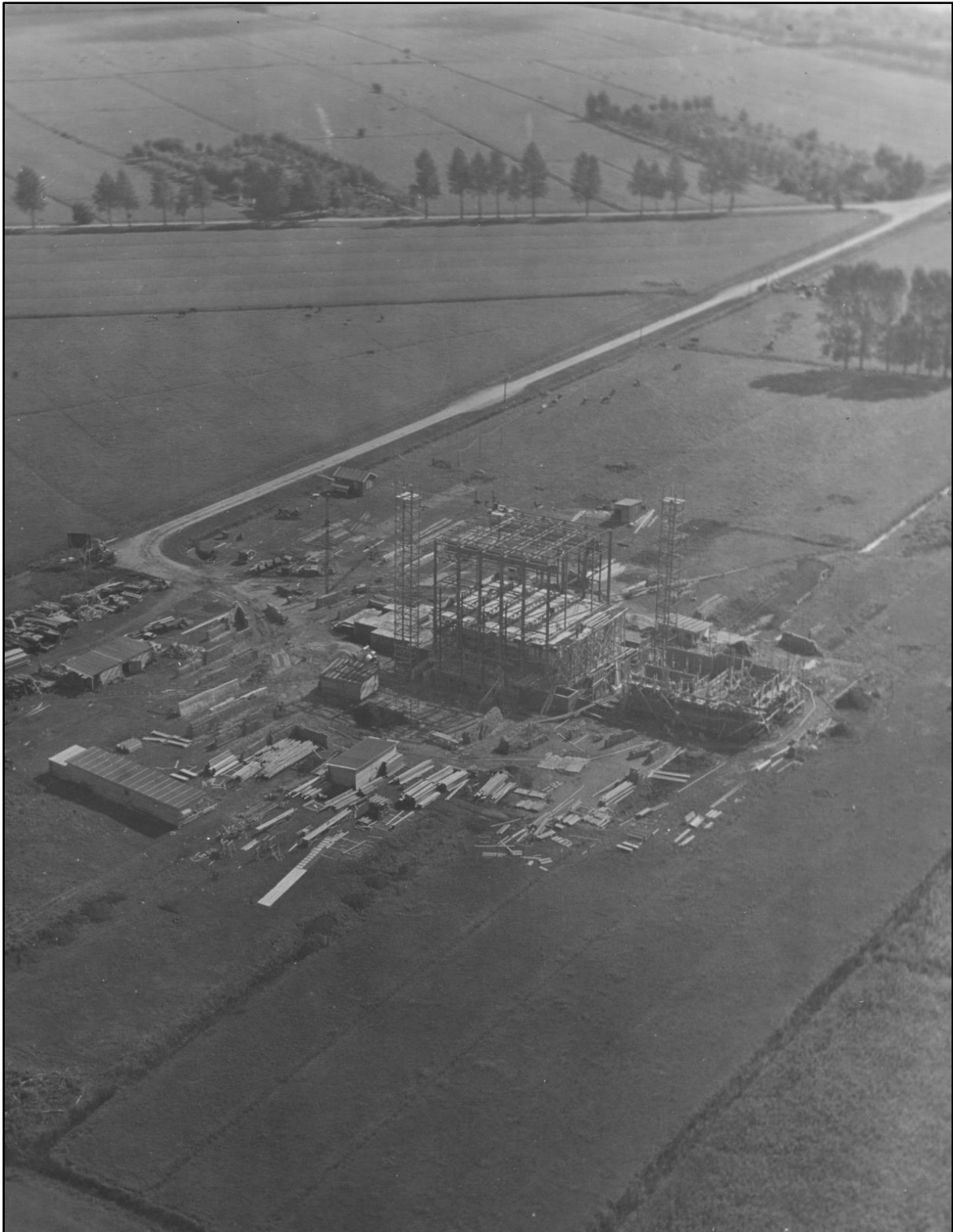
Het zendergebouw in aanbouw in 1939 (Archief Omroep Zender Museum, Map005_00014A). Het staalskelet is geproduceerd en geleverd door De Vries Robbé en gemonteerd door de Nederlandsche Electrolasch-mij te Leiden (montage). 73
