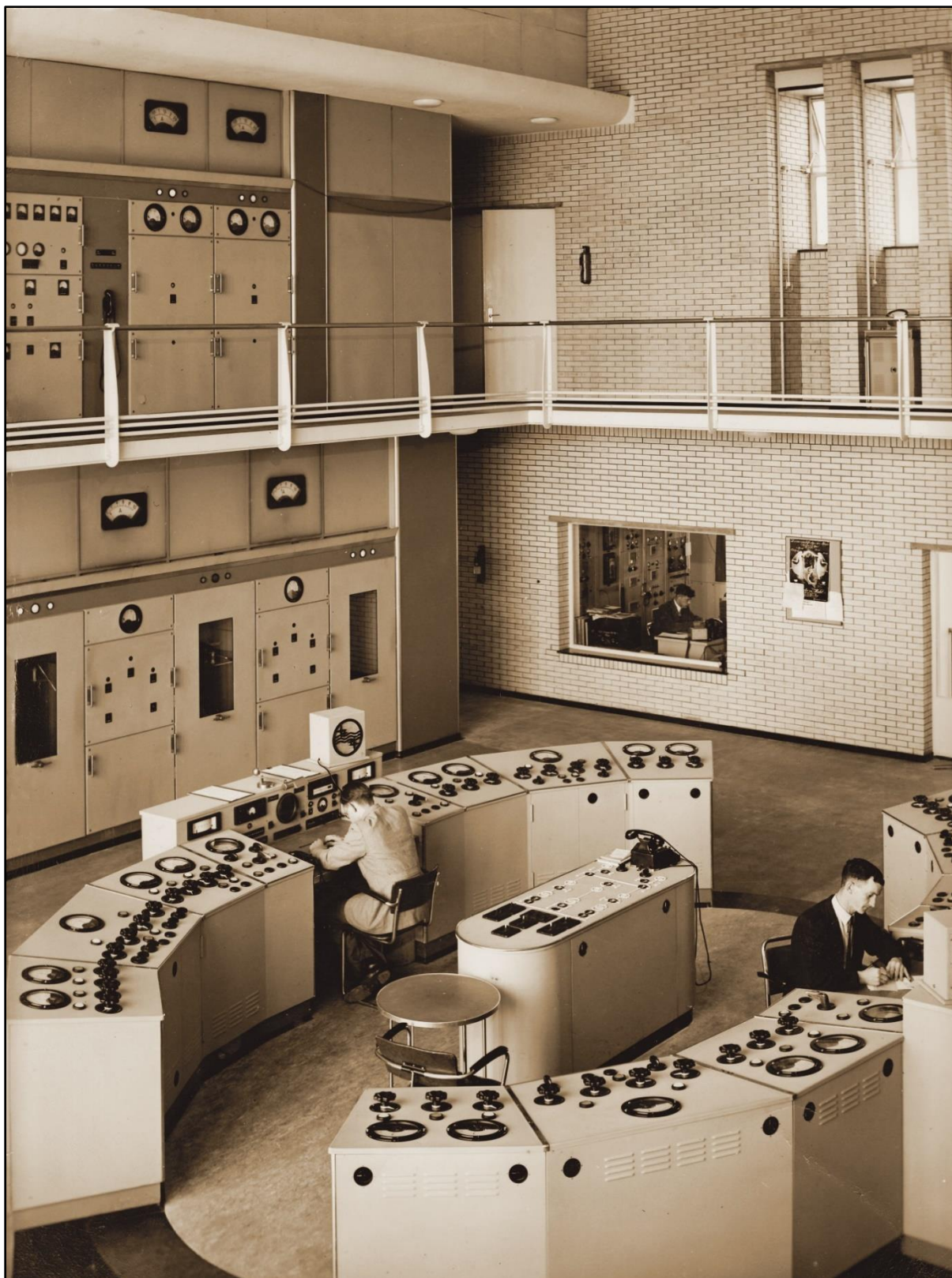
Overzicht van de zenderzaal kort na de ingebruikname in 1940, gezien naar de voorwand (Archief Omroep Zender Museum, losse foto's 0002). In het midden staat de ovale, tweedelige bedieningslesenaar. Herkenbaar is de omloop. Daarop staan de voortrappen van de zenders, daaronder de eindtrappen. Achter elke deur met glaspaneel bevond zich een zendbuis. Twee van de zes buizen van elke zenders waren als reserve bedoeld. De aanzet van het metalen plafond is midden boven op de foto zichtbaar als een koof. Rechts is een wand in schoon metselwerk te zien, uitgevoerd in verglaasde baksteen.
