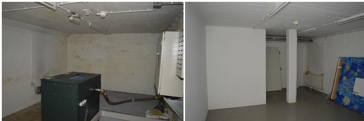
Links: overzicht van de diepe liftkelder. De liftmachine dateert uit 1992.
