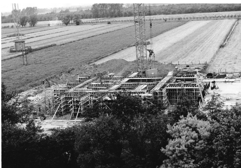
Figuur 5: bouwwerkzaamheden bunker bovengronds en dempen van de watergang
