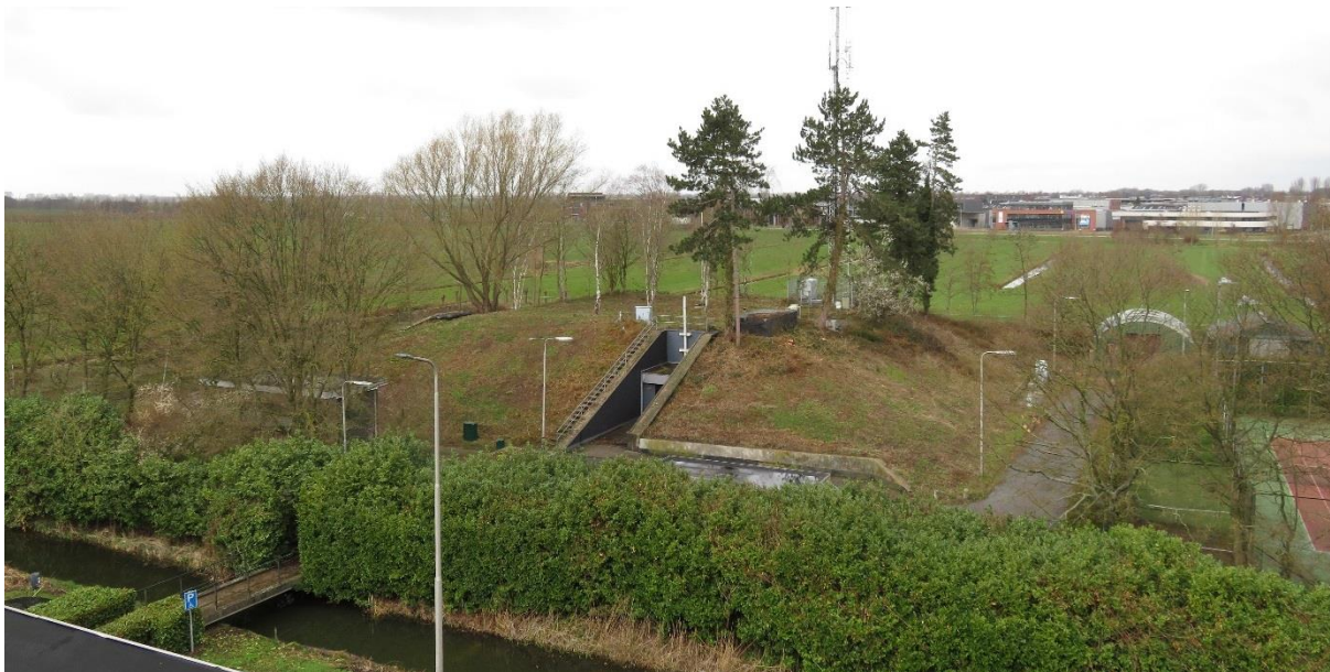
Overzicht van de bunker met aarddekking, gezien vanaf het dak van het hoofdgebouw.
