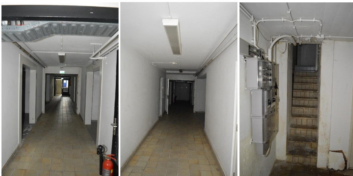
Links: overzicht van de dienstgang tussen het (voorste) trappenhuis en het lifthuis. De vloer is betegeld, de wanden en plafond zijn uitgevoerd in cementschuurwerk.
