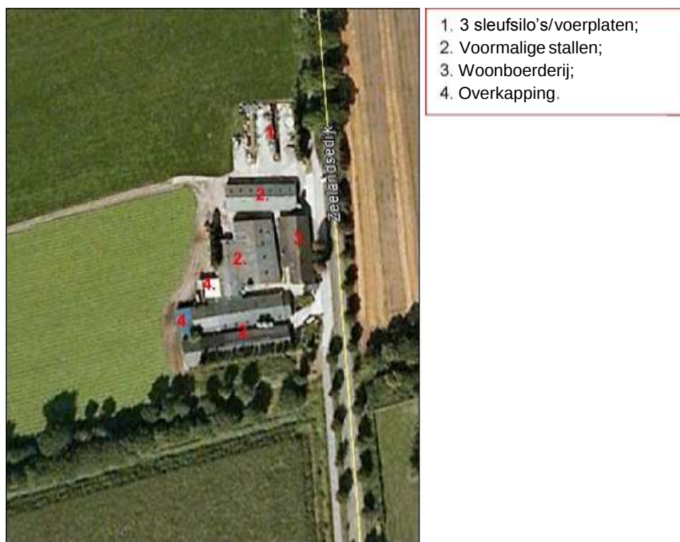
Figuur 2. Reeds gesloopte bouwwerken en gebouwen projectlocatie
