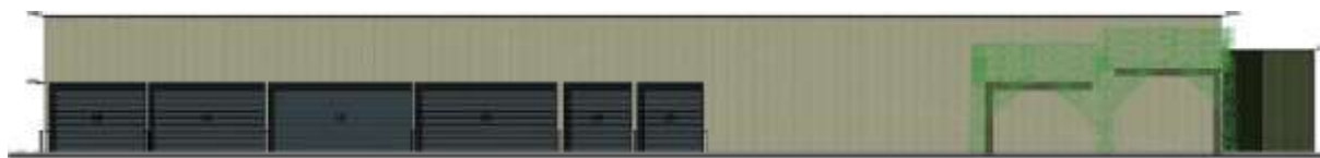
Figuur 8. Linker zijgevel — Zuid
