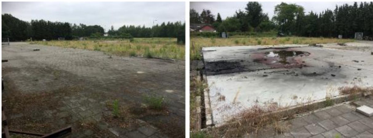
Figuur 2.2: Foto's locatie voormalige loods
