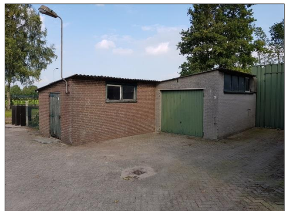
Figuur 10. Te slopen garages
