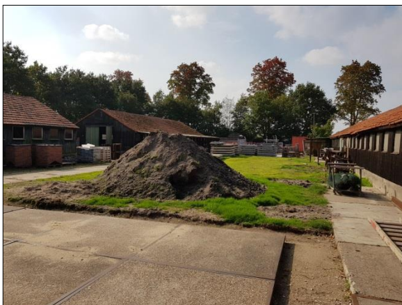
Figuur 3. Overview te slopen schuren in het plangebied
