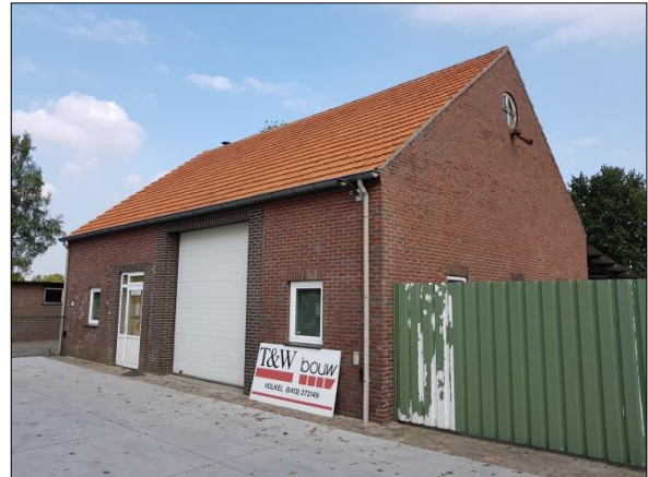
Figuur 6. Te slopen stenen schuur
