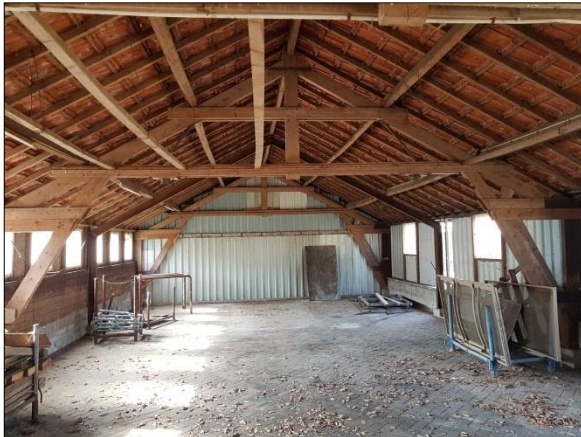
Figuur 5. Binnenzijde een van de te slopen schuren
