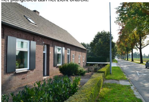
Voorzijde van de bedrijfswoning met een enkele bomenrij in de berm van de Zeelandsedijk.
