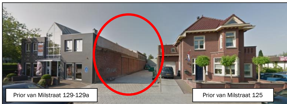
Figuur 3: Projectlocatie (bron: google.nl/maps)
