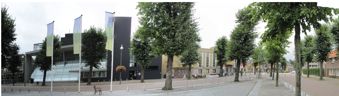
Panoramaview met zicht op Theater Markant en het bestaande gebouw op de hoek van de Markt en de Kastanjeweg (gezien vanaf de Markt))
