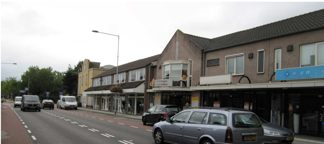
Bestaande gebouw gezien vanaf de Kastanjeweg
