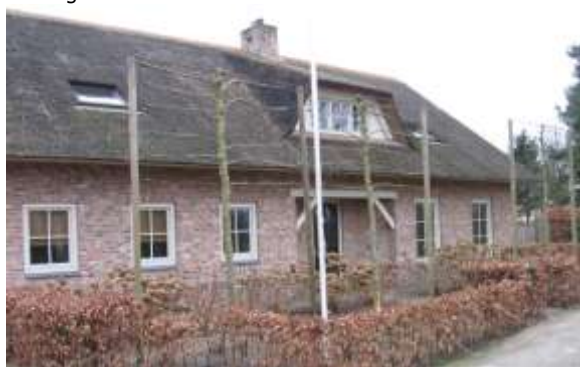
Nieuwbouw aan de Lankesstraat
